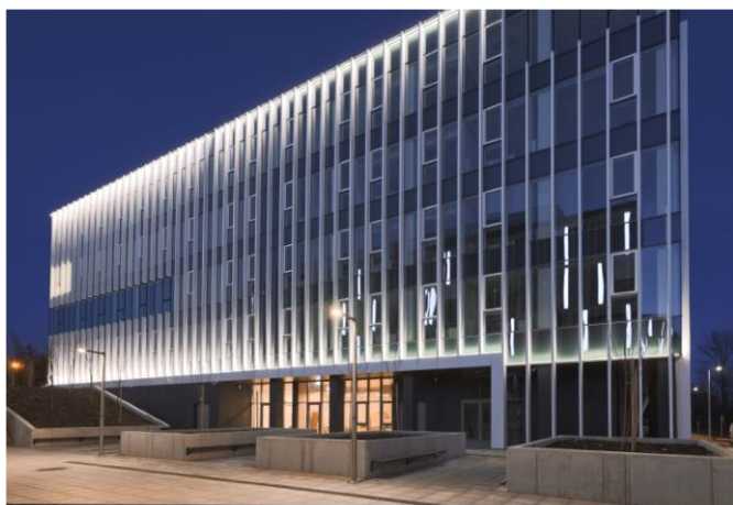
Kampus Zachodni UMCS, siedziba Wydziału Pedagogiki i Psychologii (rok budowy 2022)
