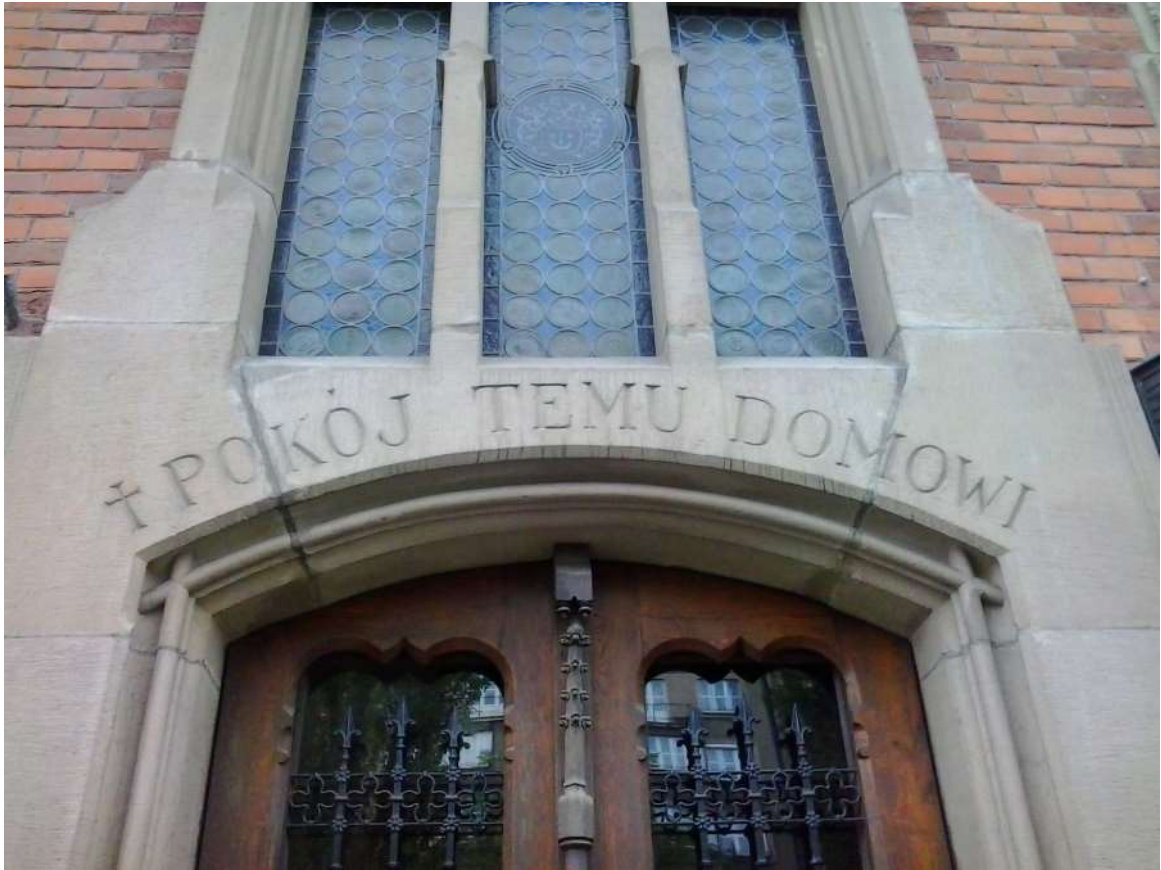
Fot. 4: Brama wejściowa domu własnego Jana Sas Zubrzyckiego, al. Słowackiego 7 (fot. K.B.)
