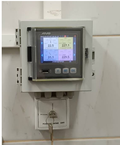
Rys. 2 Zdjęcie istniejącego rejestratora AR 970 produkcji APAR w pomieszczeniu 13 Zwierzętarńia.
