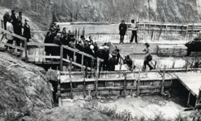
1. Wmurowanie aktu erekcyjnego pod budowę Rektoratu, koniec lat 70. XX w.
