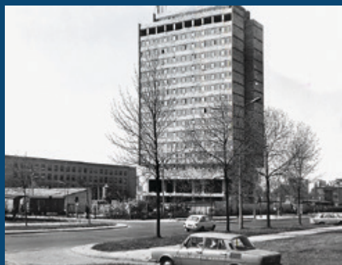
2. Budowa Rektoratu, koniec lat 70. XX w.
