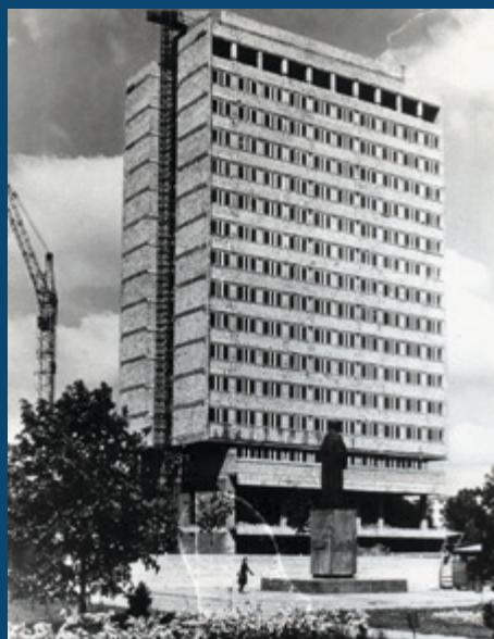
3. Budowa Rektoratu, koniec lat 70. XX w.
