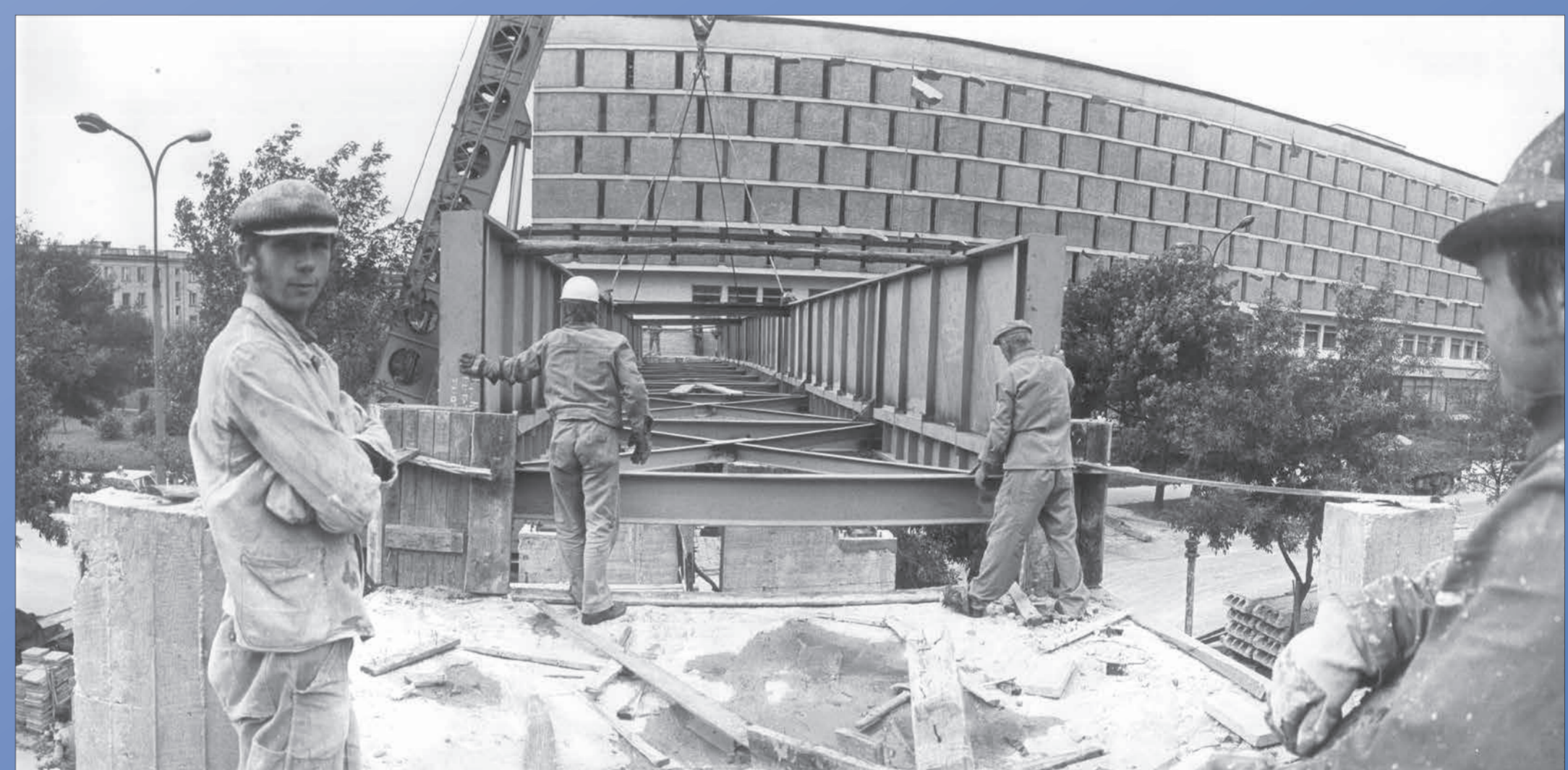
Montaż kładki łączącej budynki Rektoratu i Biblioteki Międzyuczelnianej. Lipiec 1979 r.
