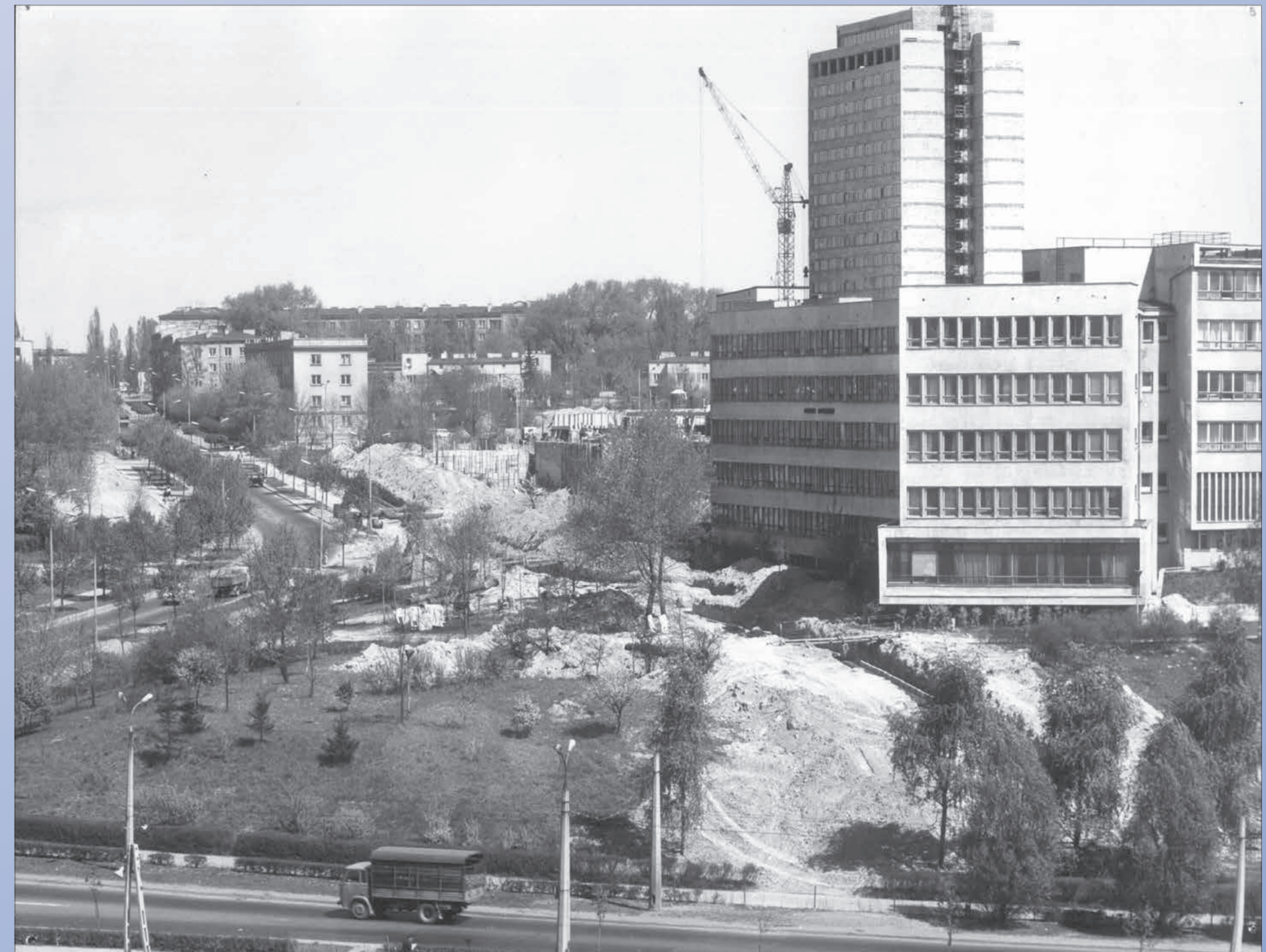
Plac budowy Rektoratu, Wydziału Ekonomicznego i Wydziału Prawa. 2 poł. lat 70.
