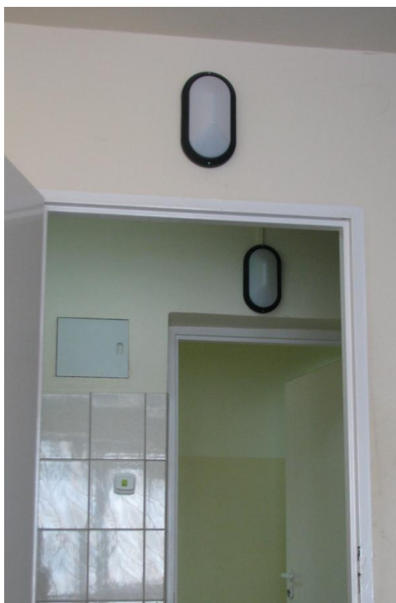
Zdjęcie nr 11 – Przykład dzwonka jako sygnalizacji świetlnej w pokoju dla studentów Głuchych
