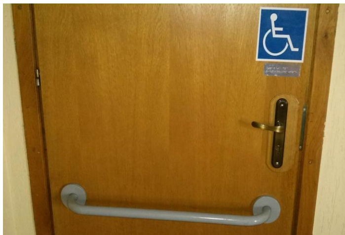
Zdjęcie nr 9, 10 – Przykład montażu antaby po wewnętrznej i zewnętrznej stronie drzwi
