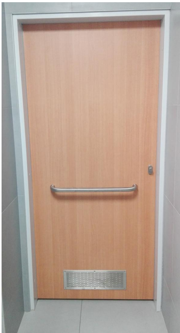
Zdjęcie nr 9, 10 – Przykład montażu antaby po wewnętrznej i zewnętrznej stronie drzwi
