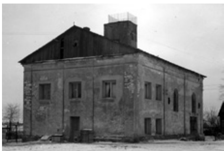
Fot. 46. Synagoga przebudowana na siedzibę Ochotniczej Straży Pożarnej, widok od strony północno-zachodniej – lata 50. XX w. Fot. NN. Źródło: Archiwum Yad Vashem
