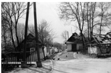
Fot. 98. Ul. Parkowa (d. Zaulek Objazdowej, Wołowa) – 1983 r. Fot. K. Mazur. Źródło: Sygowski P., 1984, Bychawa – studium historyczno-urbanistyczne
