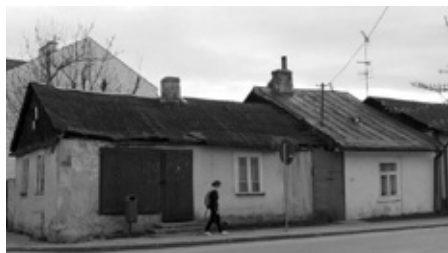
Fot. 114. Domy „pożydowskie” przy ul. P. Ściegiennego (d. Targowej) – 2000 r.
