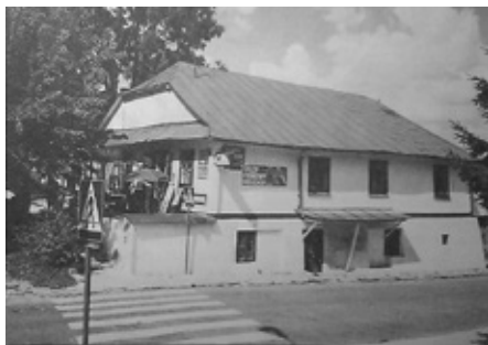
Fot. 113. Hurtownia Luterków (odnowiony budynek piekarni Piotrowskich) – 1999 r. Fot. R. Rusinek
