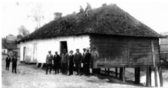
Fot. 20. Rozbiórka starej rzeźni miejskiej w Bychawie – lata 30. XX w. Fot. NN ze zbiorów M. Paneckiego. Źródło. GR, nr 16 (5/2004), s. 2
