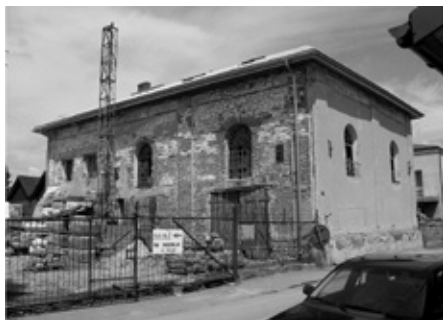
Fot. 102. Synagoga w trakcie remontu – pierwsza dekada XXI w. Fot. J. Kulik
