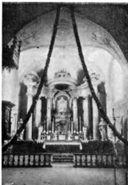
Fot. 3. Wnętrze kościoła w Bychawie.
