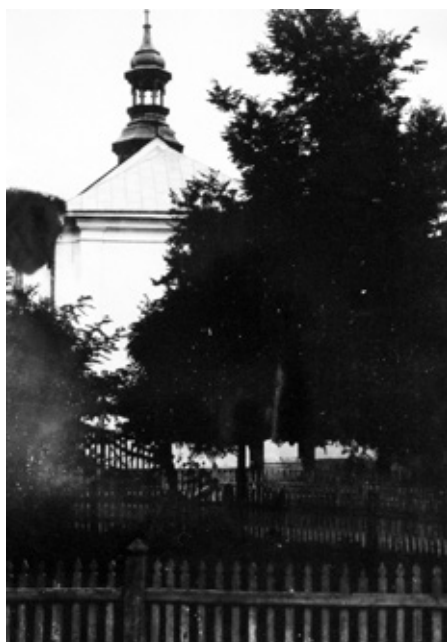
Fot. 12. Kościół, elewacja tylna – lata 20. XX w. Fot. NN.
