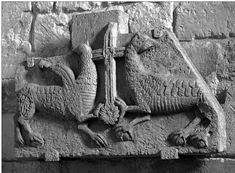
7. Uszkodzony tympanon z gryfami. Fot. T. Rodzińska-Chorąży
