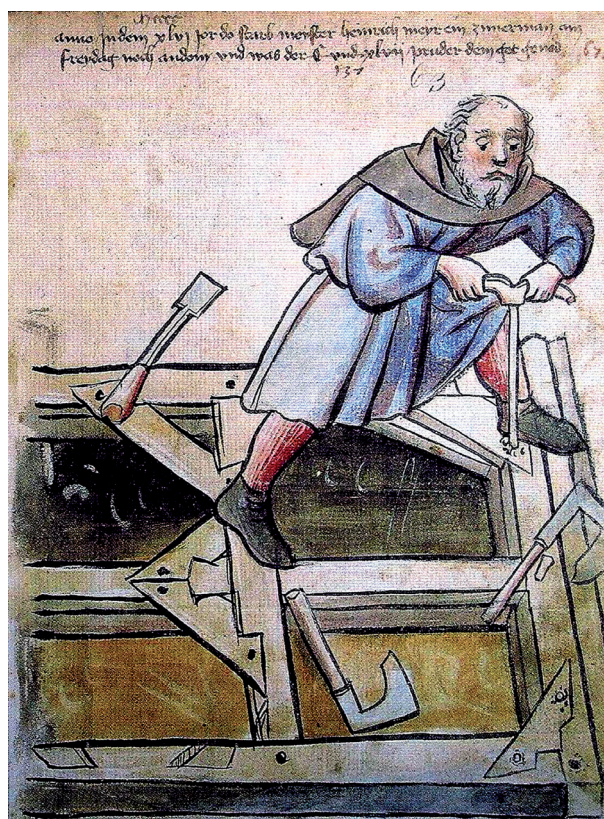
Ryc. 3. Cieśla skręcający konstrukcje drewniane więzby dachowej (za: W. Mączyński 2010)
