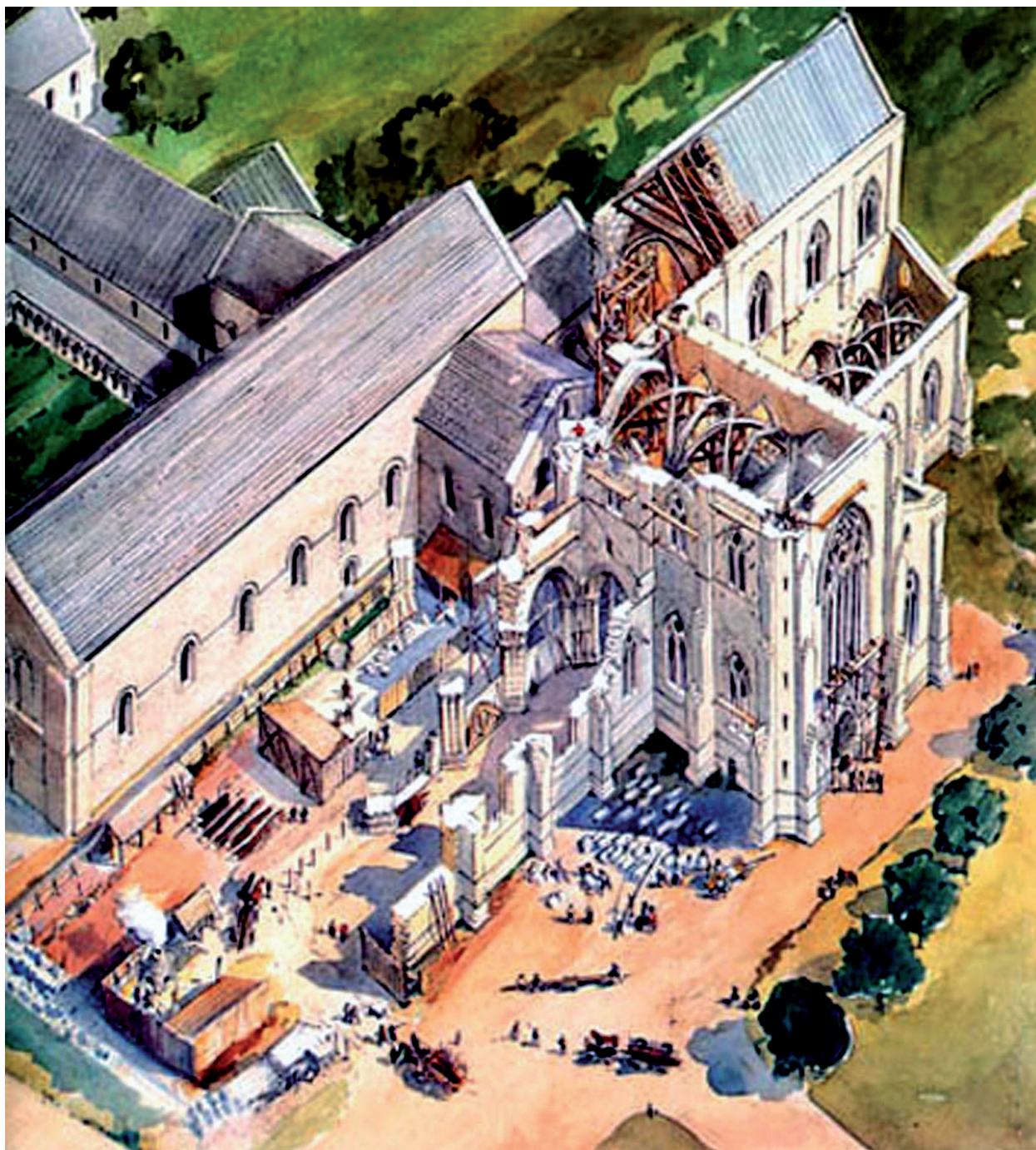
Ryc. 2. Ideowe przedstawienie placu budowy opactwa w Tintern (wg Robinson 1990: 25)
