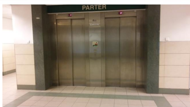
Windy wewnątrz budynku
