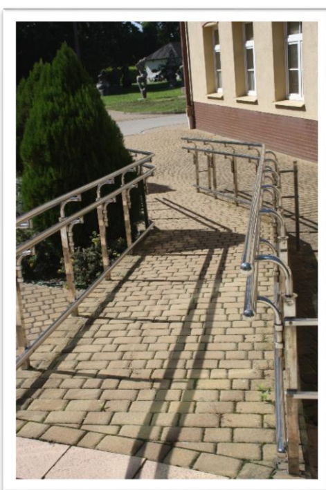
Podjazd z drugiej strony budynku
