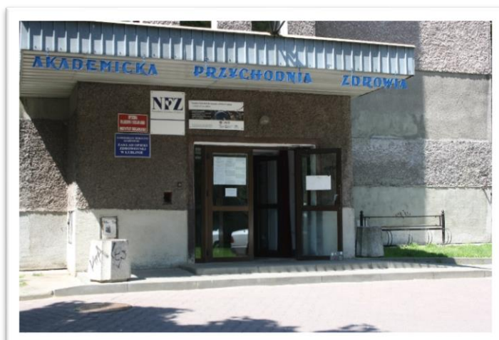
Wejście do budynku z podjazdem
