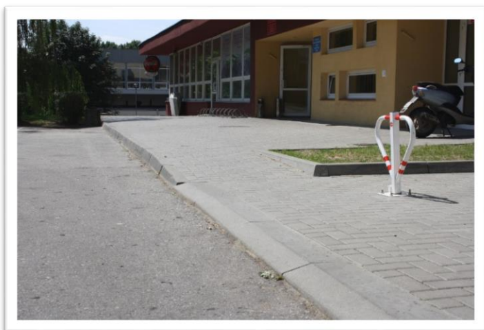
Niwelacja krawężnika przy wejściu do Domu Studenckiego
