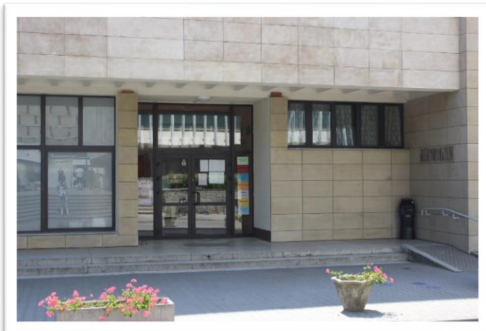
Wejście do budynku z podjazdem
