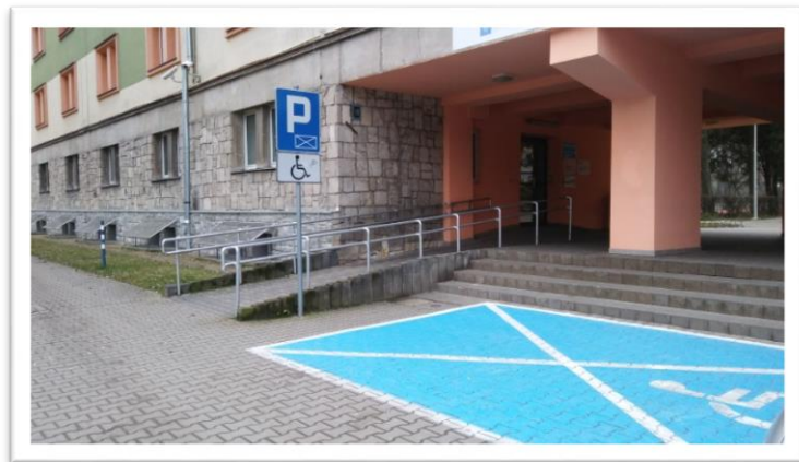
Miejsce parkingowe oraz podjazd z poręczami
