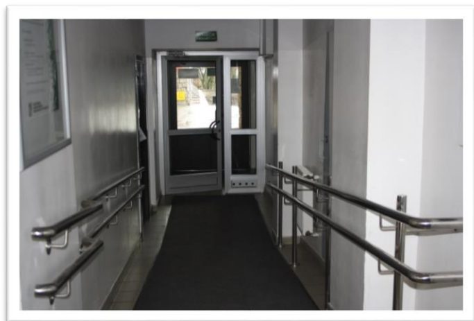
Wewnątrz budynku pochylnia z poręczami
