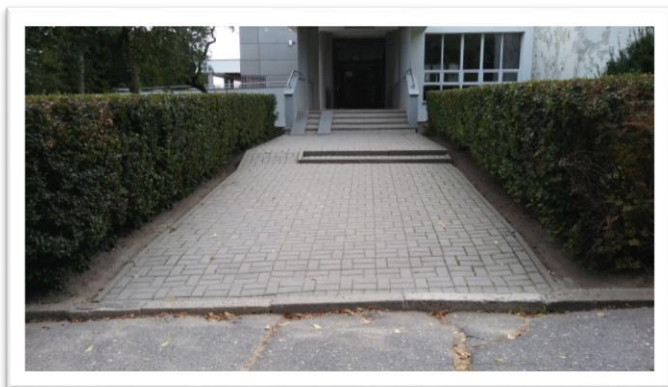
Schody na chodnikach przed budynkiem
