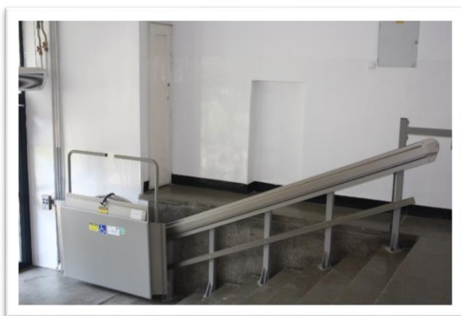
Platforma przyschodowa na półpiętrze
