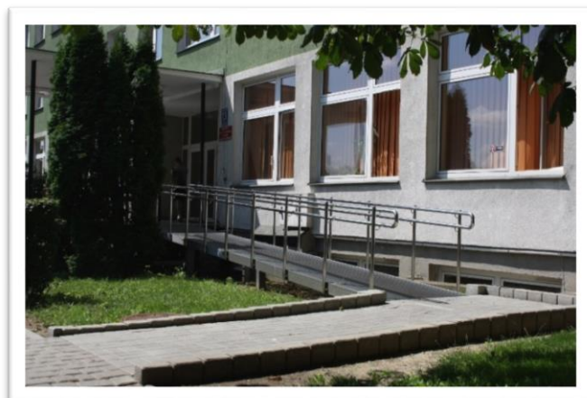
Podjazd przy głównym wejściu do domu studenckiego
