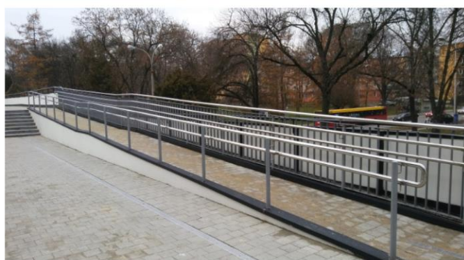
Pochylnia dla osób na wózkach w stronę kładki dla pieszych nad ul. Sowińskiego
