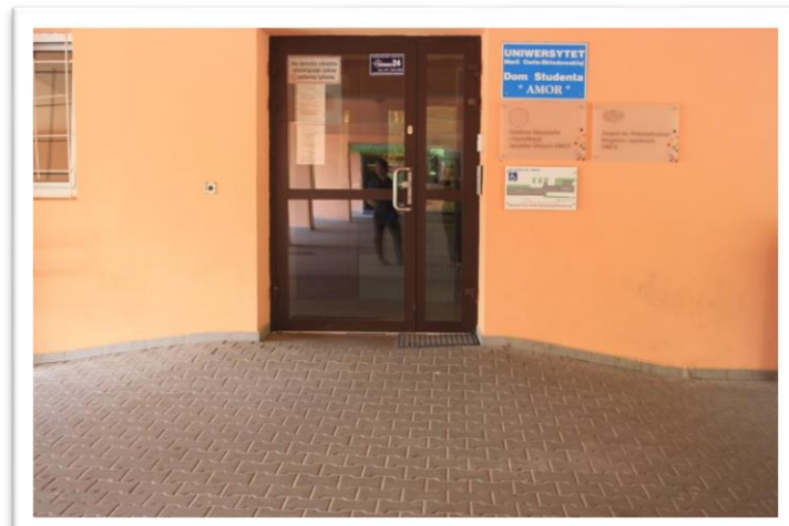
Wejście do budynku
