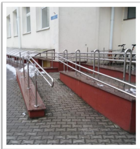
Wejście do budynku z podjazdem dla osób niepełnosprawnych
