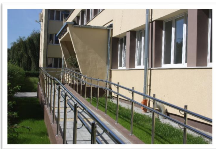
Podjazd do budynku przy ul. Glinianej 33
