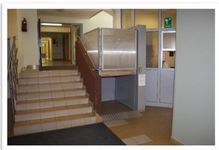
Platforma pionowa wewnątrz budynku na parterze
