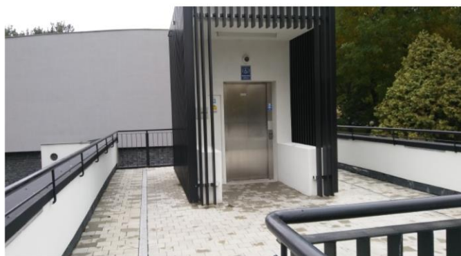
Winda na kładce dla pieszych nad ul. Sowińskiego przy ACK „Chatka Żaka”
