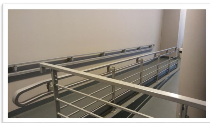
Podjazd wewnętrzny do przejścia do budynku A
