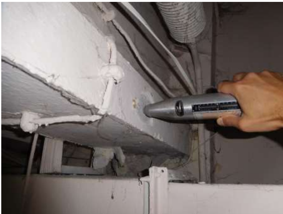
Fot. 1: Pomiar 1 – pas dolny dźwigara w osi 7
