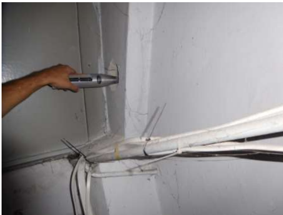
Fot. 4: Pomiar 4 – wieniec nad słupem w osi C/4
