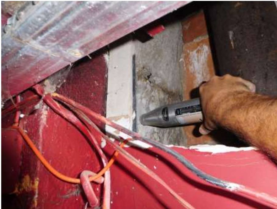
Fot. 2: Pomiar 2 – słup w osi C/7
