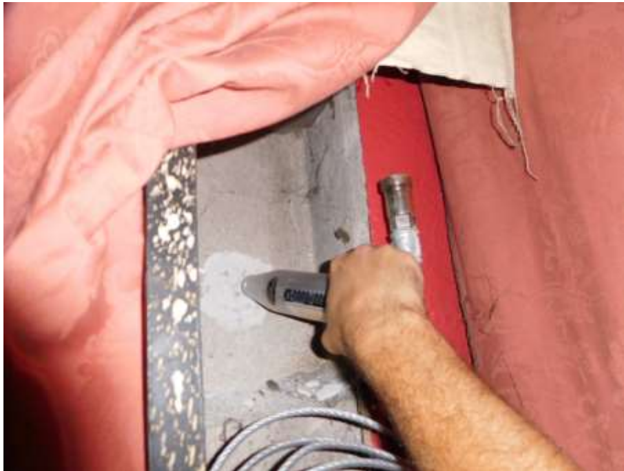
Fot. 3: Pomiar 3 – średnik dźwigara w osi A/6
