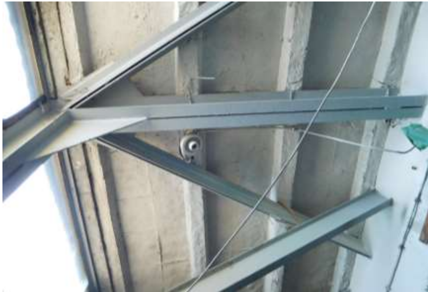
Fot. 4: Fragment ramy dachowej wraz ze stężeniami połaciowymi
