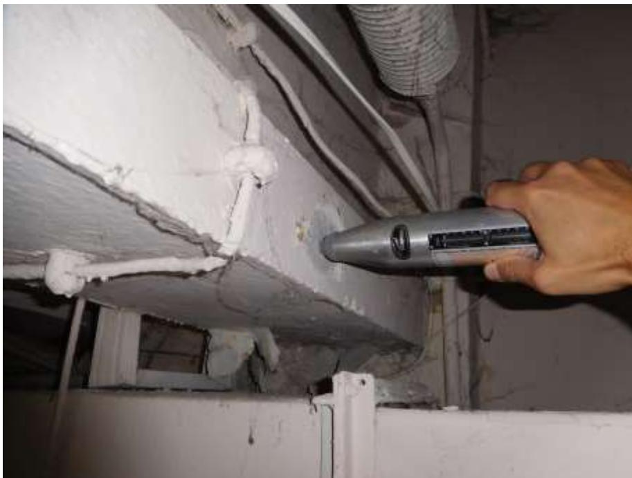
Fot. 28: Przykład badania dźwigara strunobetonowego młotkiem Schmidta
