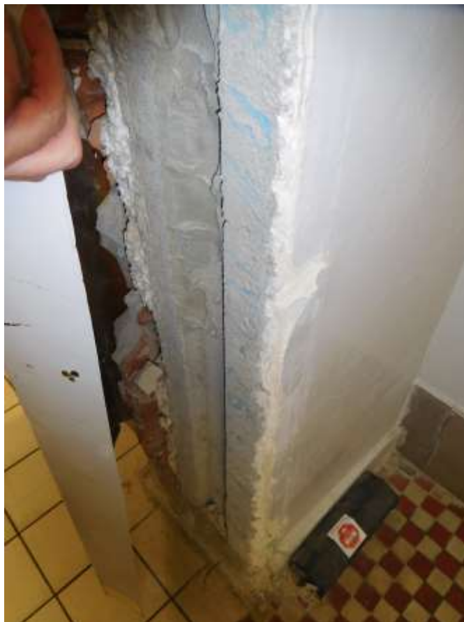
Fot. 3: Fragment prefabrykowanej ściany kanałowej w poziomie parteru w osi E
