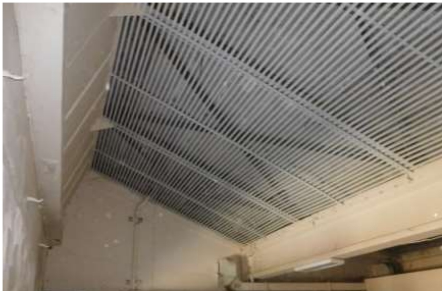
Fot. 5: Fragment konstrukcji dachu wraz ze strefą oparcia na dźwigarze strunobetonowym
