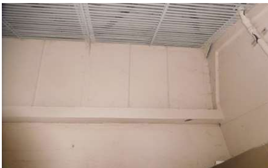
Fot. 2: Widok belki wieńczącej zabudowanej w ścianie zewnętrznej
