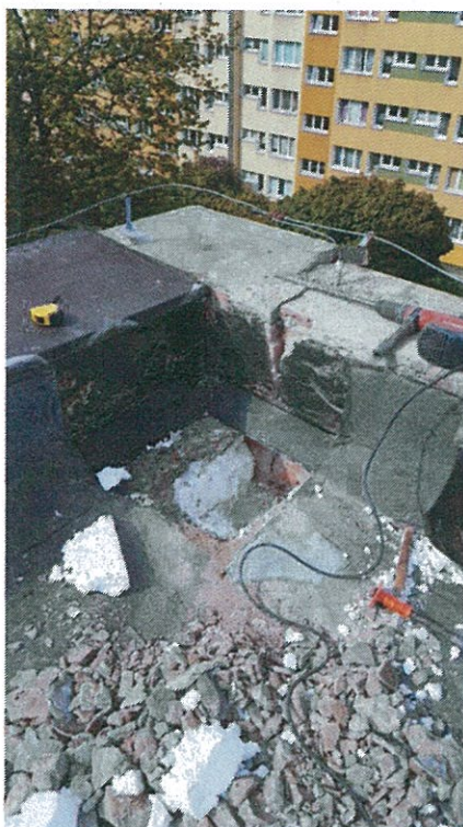
Fot.5. Odkrywka D.1. w narożu południowo-zachodnim budynku.
