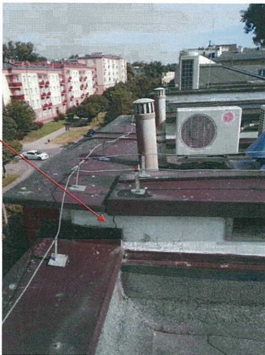
Fot.8. Widok połączenia ściany kominowej z attyką.
