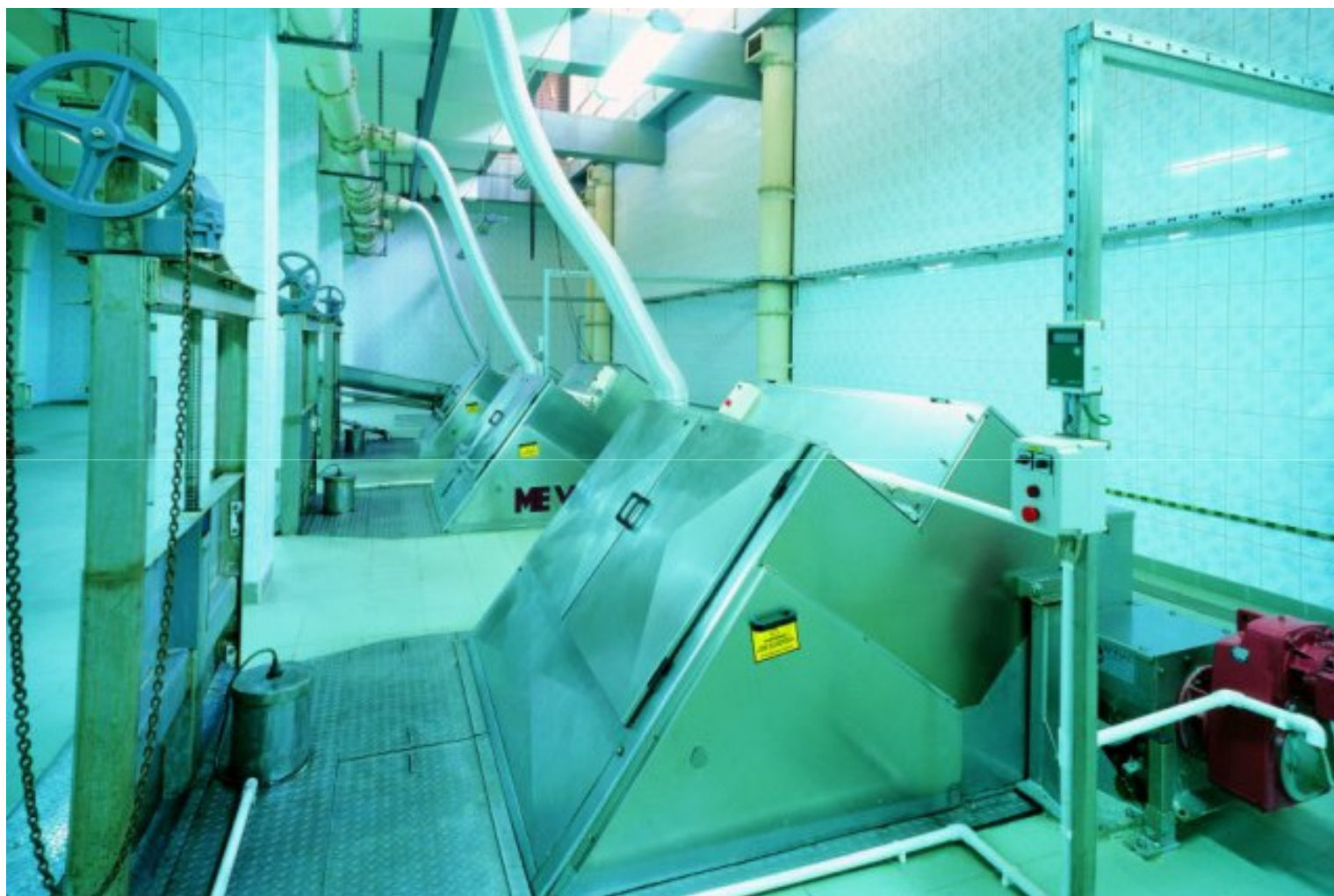
Kraty w oczyszczalni „Hajdów” – pełna hermetyzacja
