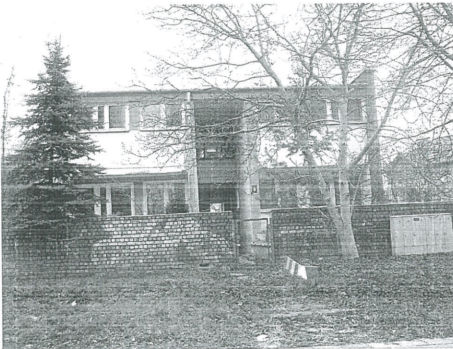
Fot.2 Elewacja wschodnia
