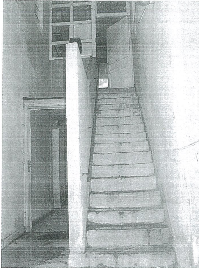
Fot.5 Schody wejściowe na piętro
