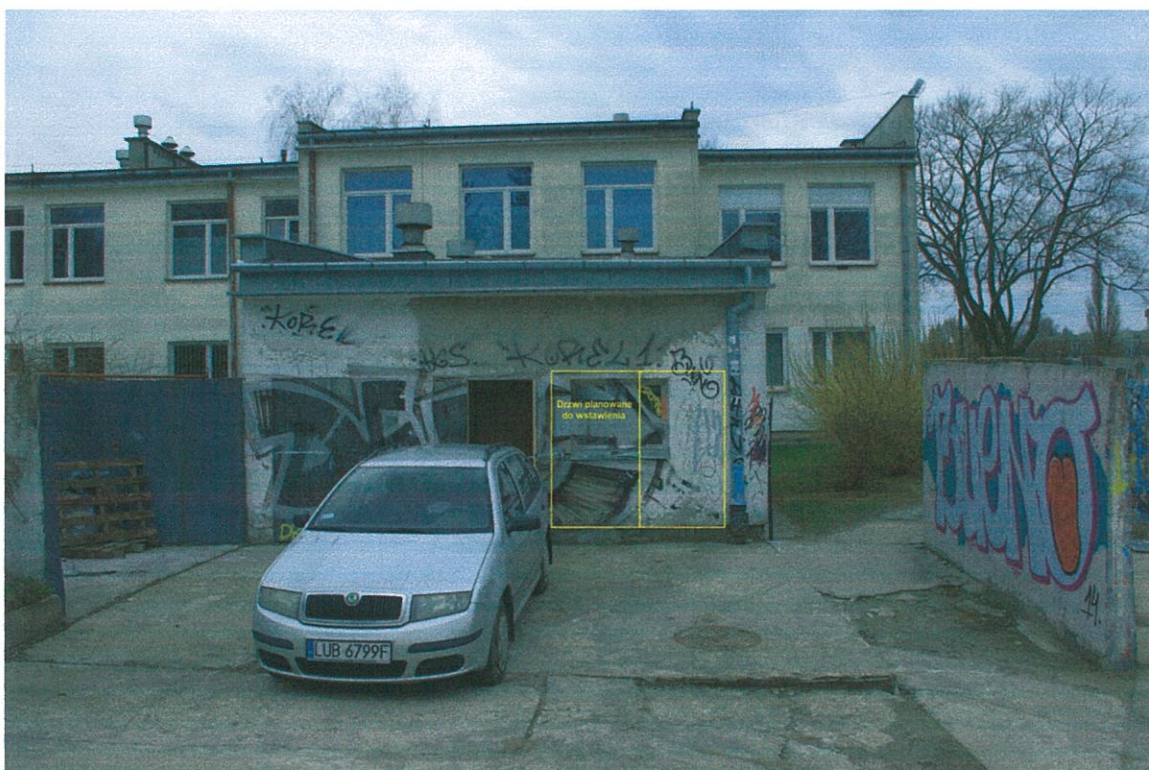
Ogólny widok budynku wymiennikowni z zaznaczeniem lokalizacji dodatkowych drzwi dwuskrzydłowych typu garażowego.
