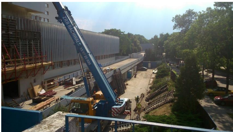
Fot 8. Elewacja Kładka nr 1
