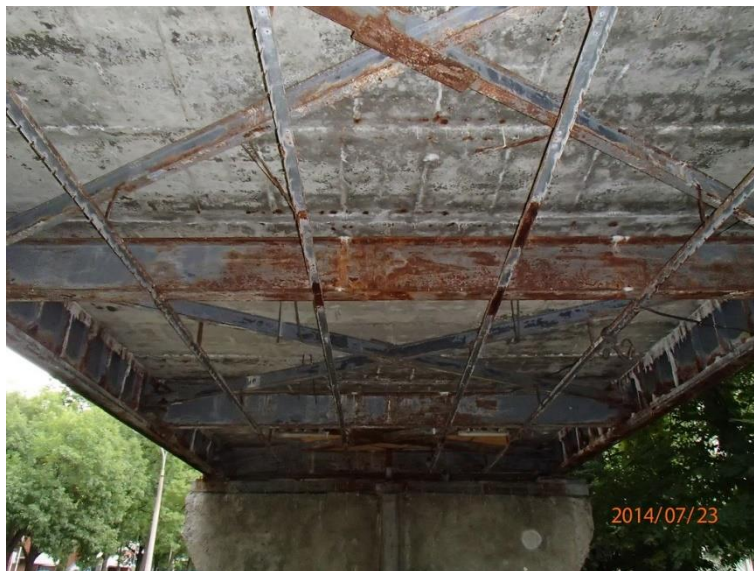
Fot 24. Kładka nr 1, widok od spodu przy kiosku ruchu.
