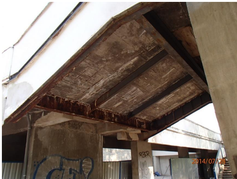
Fot 37. Kładka nr 1, widok od spodu przy wydziale ekonomii.
