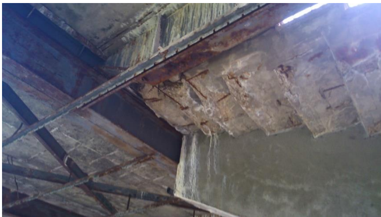
Fot 20. Kładka nr 1, widok od spodu przy chatce Żaka – schody.
