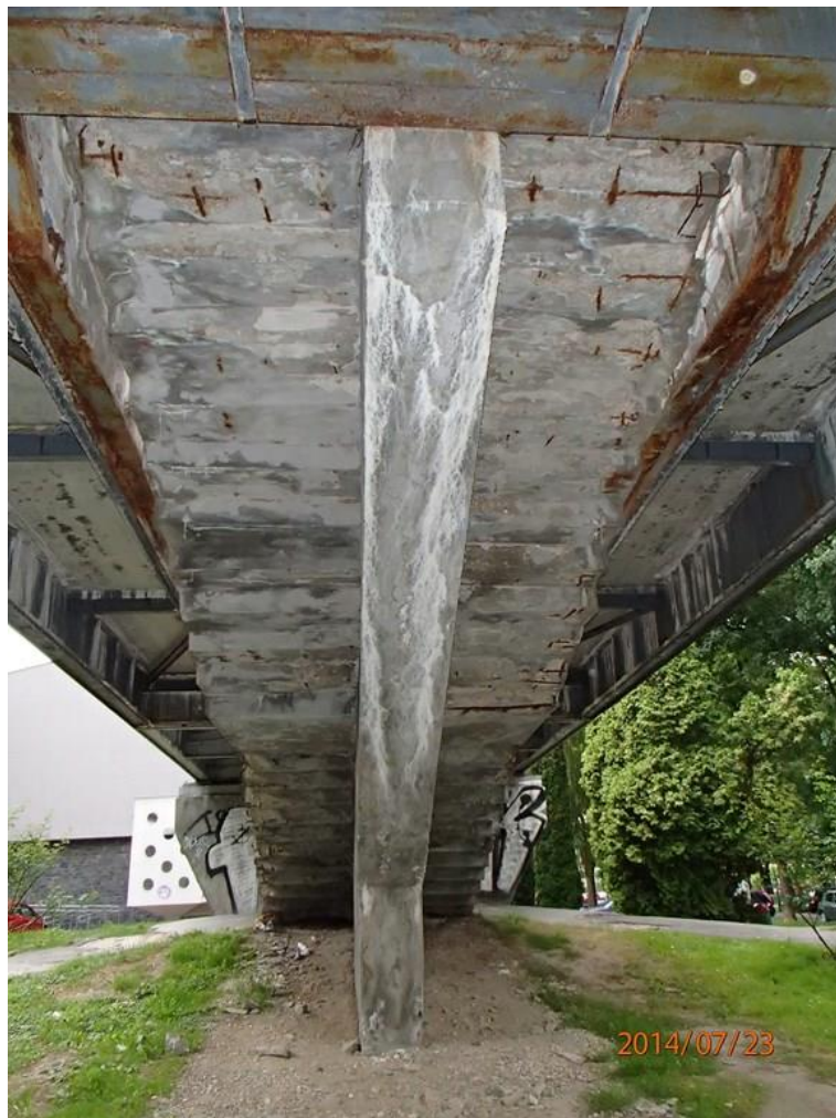
Fot 56. Kładka nr 1, widok od spodu przy chatce Żaka – schody.
