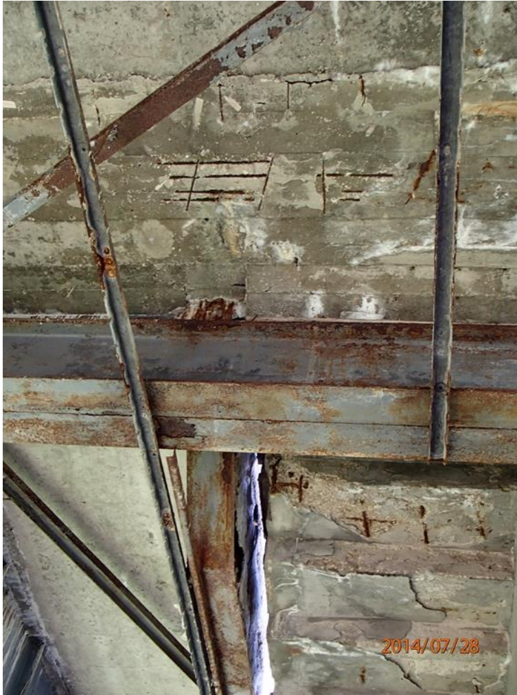
Fot 19. Kładka nr 1, widok od spodu przy chatce Żaka – schody.
