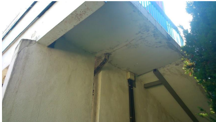
Fot 81. Spód, Kładka nr 2, przy bibliotece.
