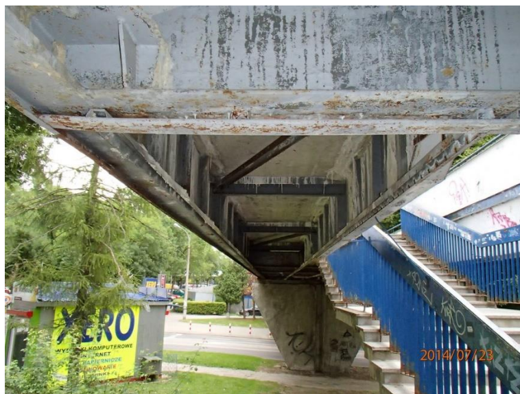
Fot 18. Kładka nr 1, widok od spodu przy chatce Żaka – schody.
