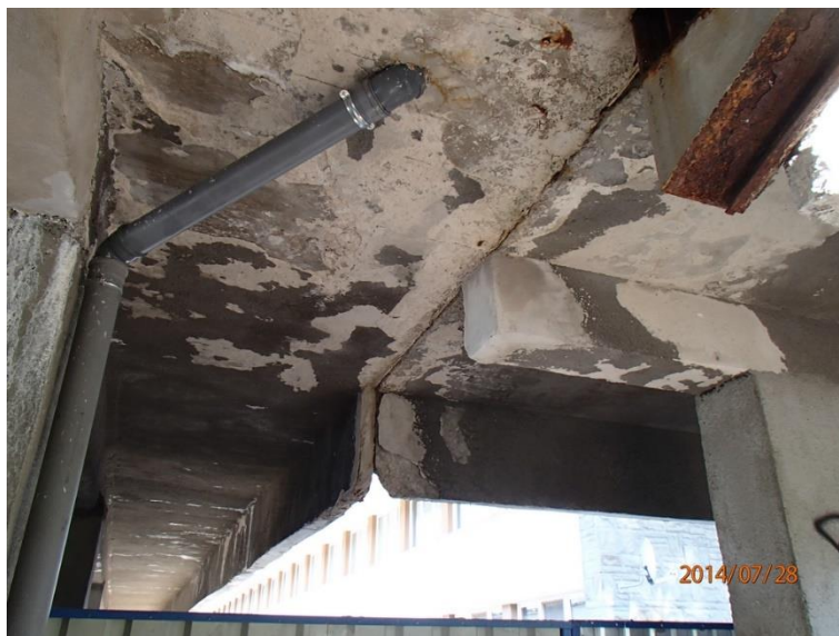
Fot 44. Kładka nr 1, widok od spodu przy wydziale ekonomii.
