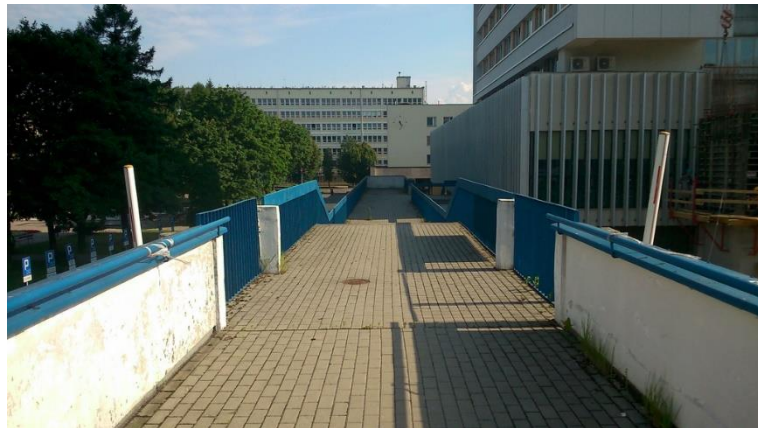
Fot 121. Barierki, Kładka nr 2, nad ul.Radziszewskiego.
