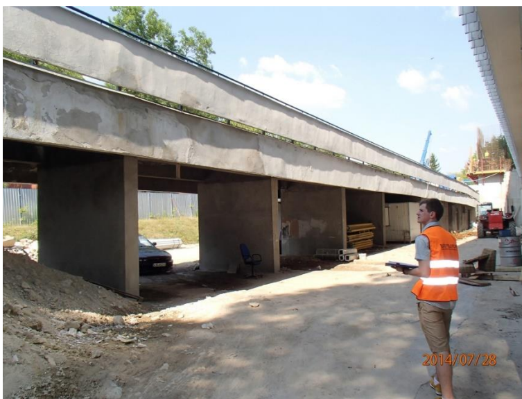
Fot 9. Elewacja Kładka nr 1
