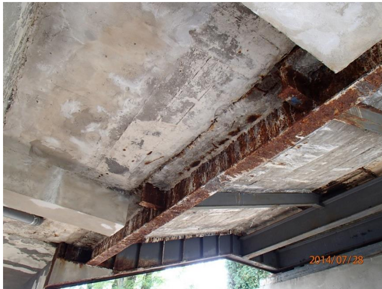
Fot 42. Kładka nr 1, widok od spodu przy wydziale ekonomii.
