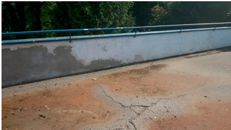
Fot 62. Kładka nr 1, bariera
