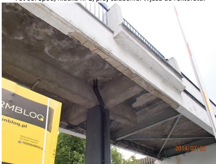
Fot 96. Spód, Kładka nr 2, przy szlabanie. Wjazd do rektoratu.
