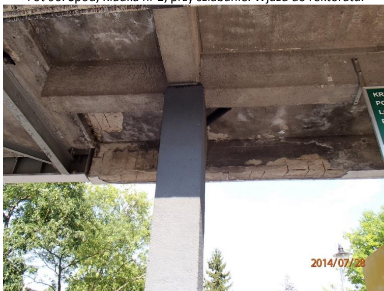
Fot 91. Spód, Kładka nr 2, przy szlabanie. Wjazd do rektoratu.
