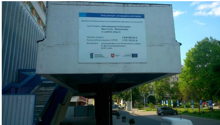
Fot 70. Kładka nr 2, elewacja
