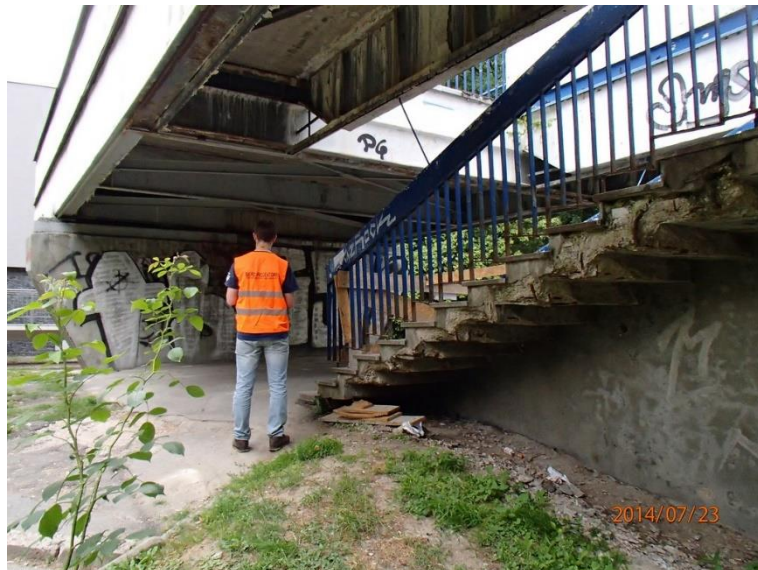
Fot 52. Kładka nr 1, widok od spodu przy chatce Żaka – schody.
