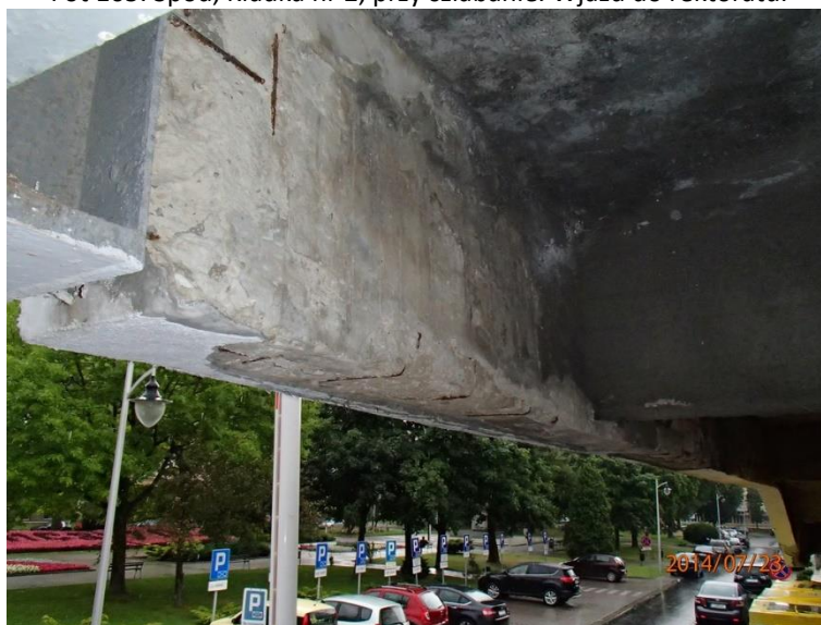
Fot 106. Spód, Kładka nr 2, przy szlabanie. Wjazd do rektoratu.
