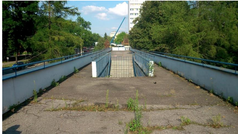
Fot 51. Kładka nr 1, schody
