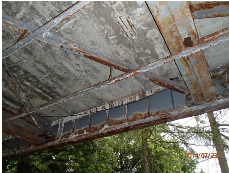
Fot 21. Kładka nr 1, widok od spodu przy kiosku ruchu.
