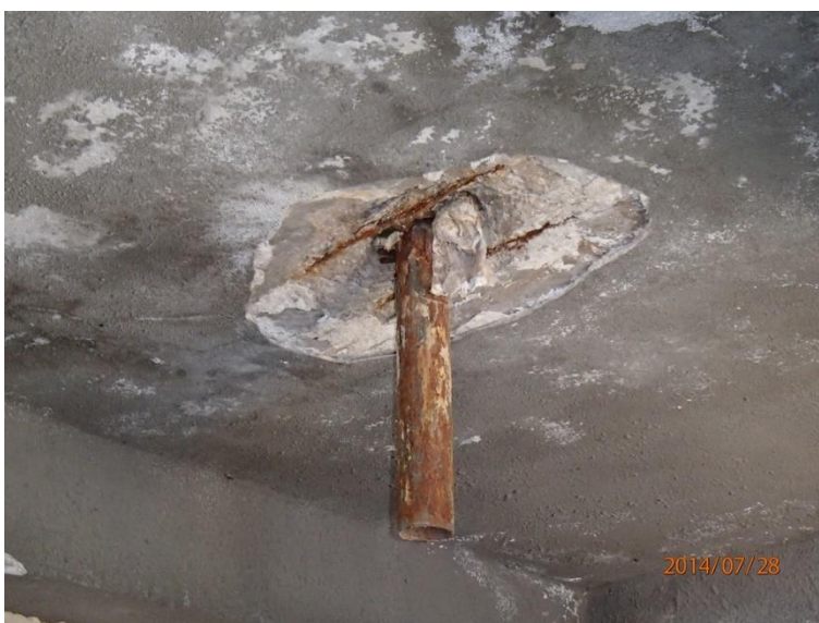
Fot 48. Kładka nr 1, widok od spodu przy wydziale ekonomii.
