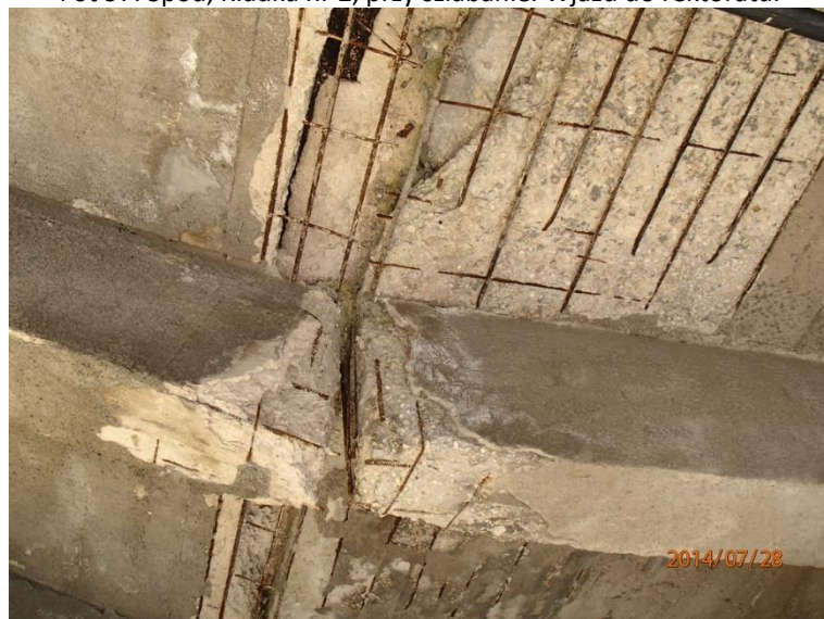
Fot 98. Spód, Kładka nr 2, przy szlabanie. Wjazd do rektoratu.
