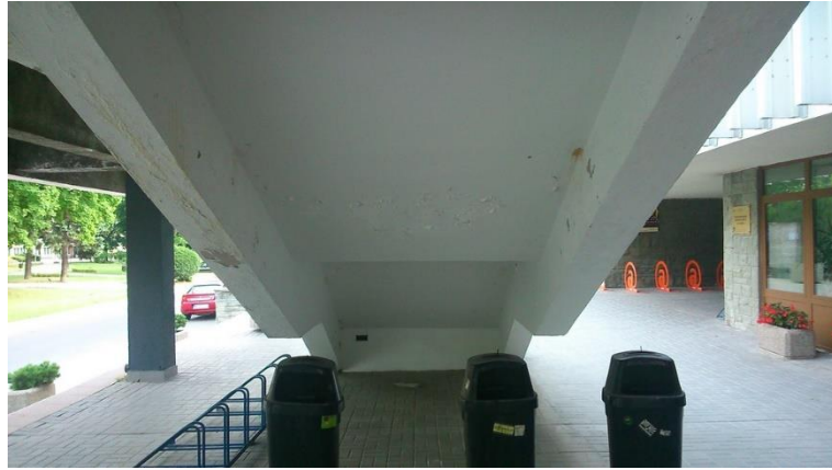
Fot 113. Schody od spodu, Kładka nr 2, przy rektoracie.
