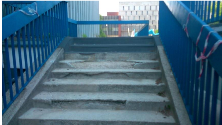
Fot 114. Schody, Kładka nr 2, przy rektoracie.
