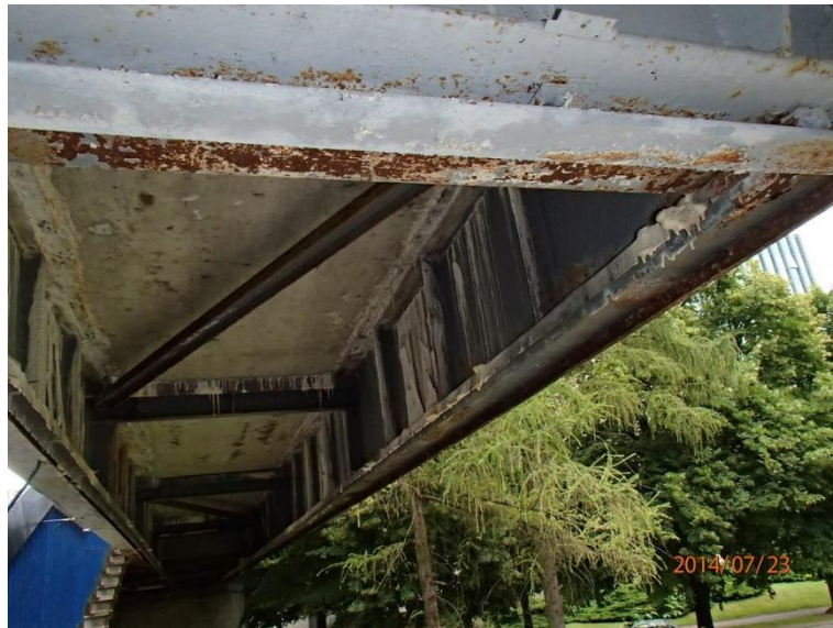
Fot 17. Kładka nr 1, widok od spodu przy chatce Żaka – schody.
