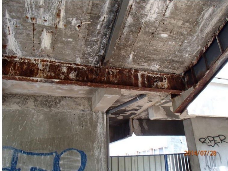
Fot 39. Kładka nr 1, widok od spodu przy wydziale ekonomii.
