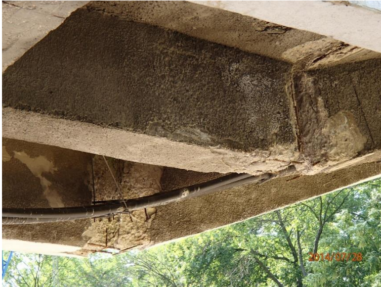
Fot 100. Spód, Kładka nr 2, przy szlabanie. Wjazd do rektoratu.
