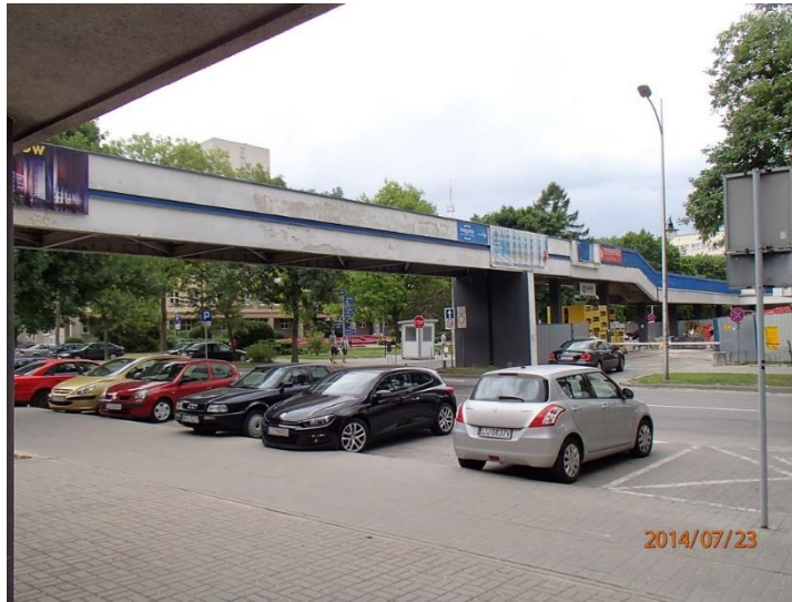
Fot 67. Kładka nr 2, elewacja
