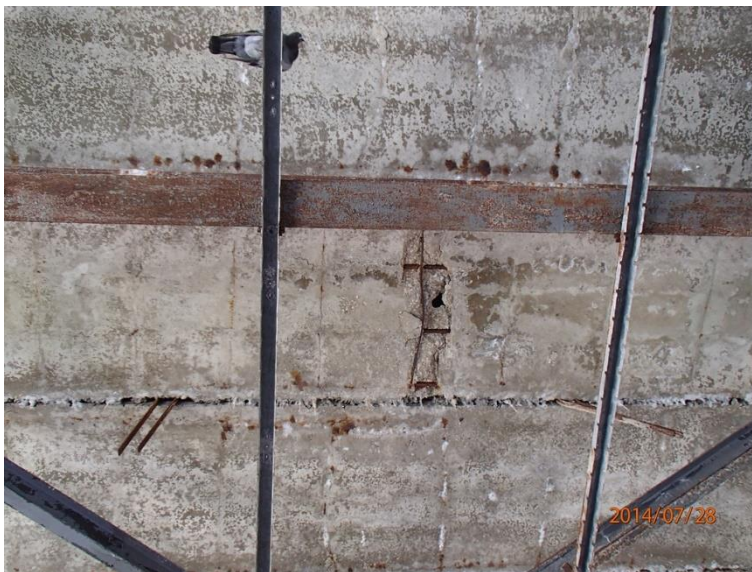
Fot 15. Kładka nr 1, widok od spodu przy kiosku ruchu
