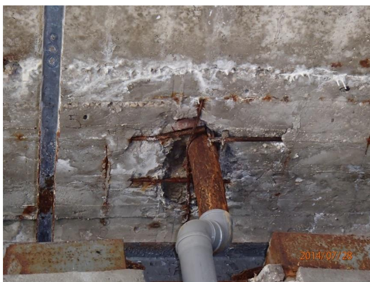
Fot 26. Kładka nr 1, widok od spodu przy wydziale ekonomii.
