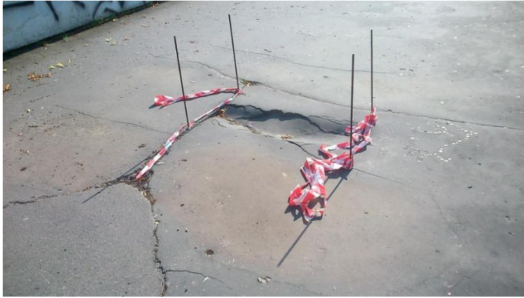
Fot 64. Kładka nr 1, powierzchnia.
