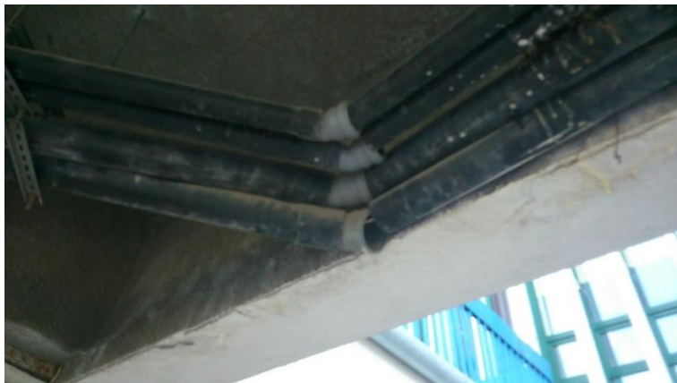
Fot 76. Spód, Kładka nr 2, przy rektoracie.
