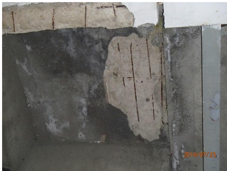
Fot 93. Spód, Kładka nr 2. Wjazd do rektoratu.
