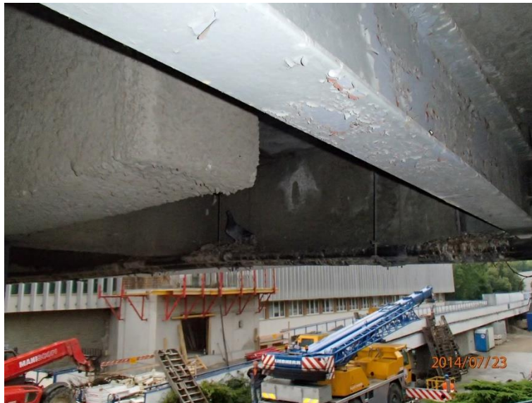
Fot 105. Spód, Kładka nr 2, przy szlabanie. Wjazd do rektoratu.
