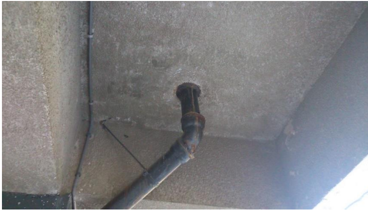
Fot 77. Spód, Kładka nr 2, przy rektoracie.
