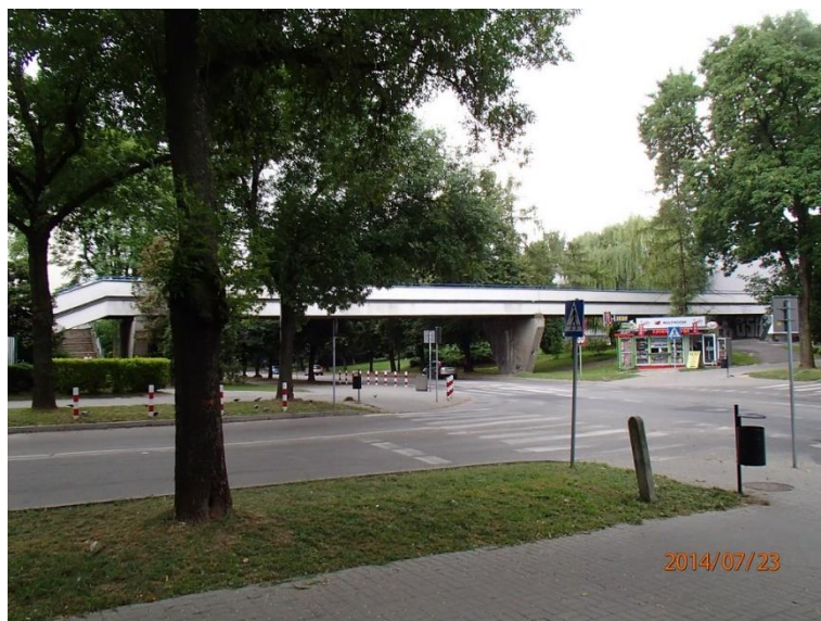
Fot 6. Elewacja Kładka nr 1
