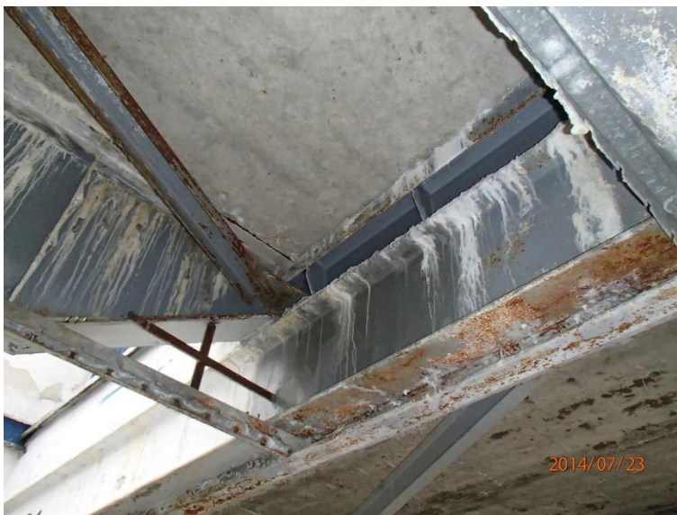
Fot 16. Kładka nr 1, widok od spodu przy chatce Żaka – schody.
