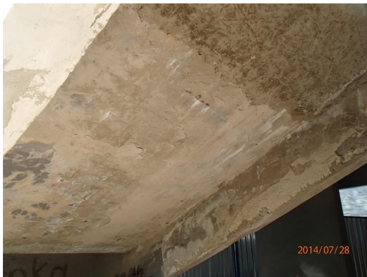
Fot 126. Schody, Kładka nr 3, od spodu
