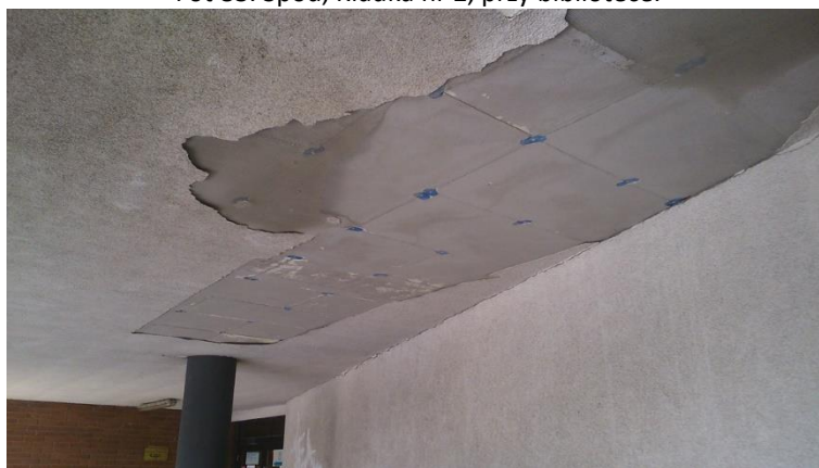
Fot 84. Spód, Kładka nr 2, przy bibliotece.
