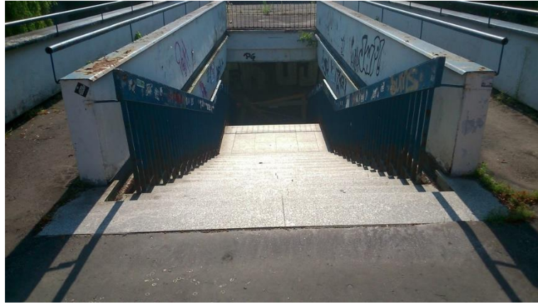
Fot 50. Kładka nr 1, schody.
