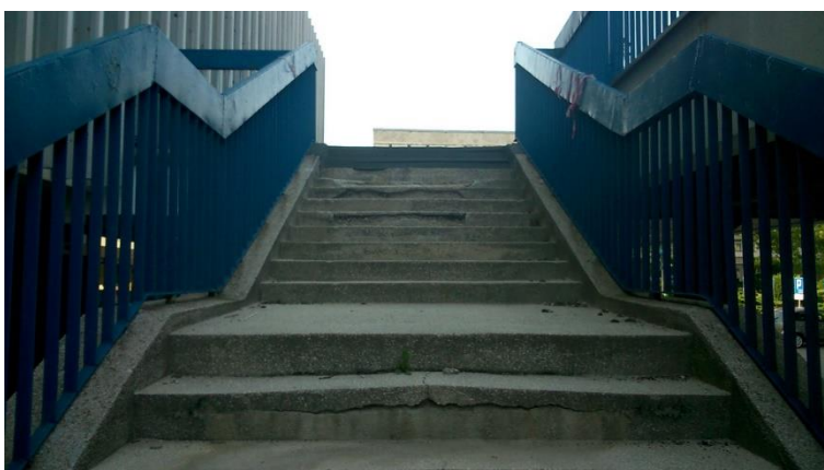
Fot 112. Schody, Kładka nr 2, przy rektoracie.
