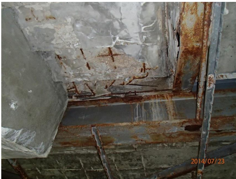
Fot 58. Kładka nr 1, widok od spodu przy chatce Żaka – schody.
