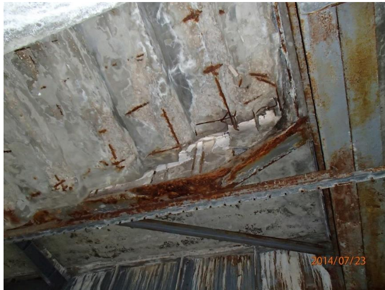
Fot 55. Kładka nr 1, widok od spodu przy chatce Żaka – schody.
