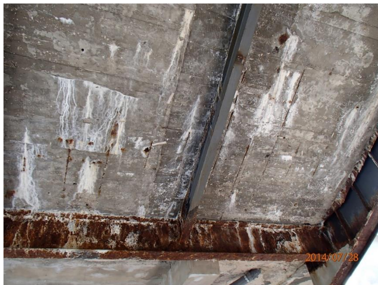
Fot 41. Kładka nr 1, widok od spodu przy wydziale ekonomii.
