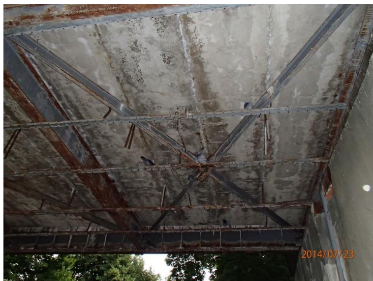
Fot 22. Kładka nr 1, widok od spodu przy kiosku ruchu.
