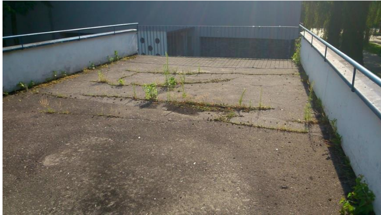
Fot 60. Kładka nr 1, bariera
