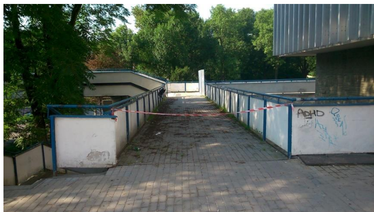
Fot 122. Elewacja, Kładka nr 3
