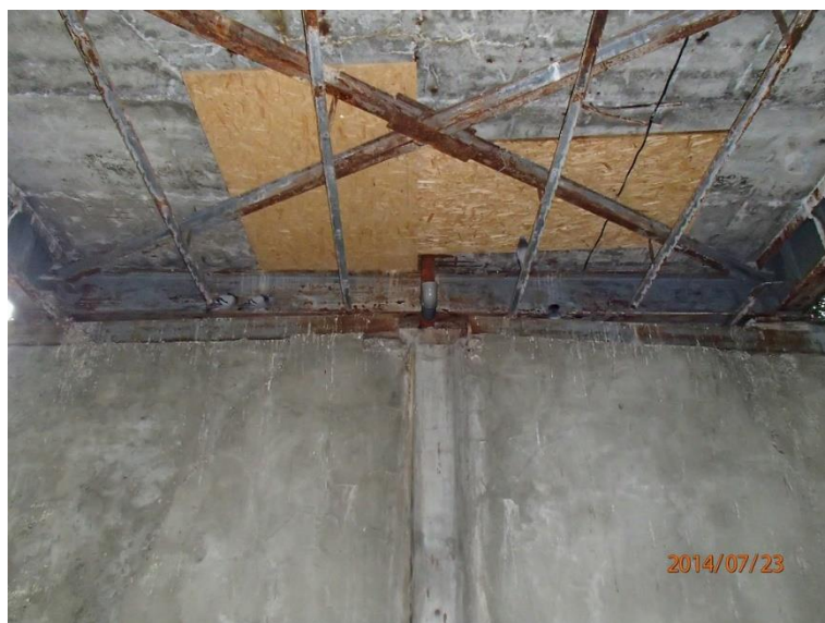
Fot 35. Kładka nr 1, widok od spodu po stronie wydziału ekonomii.
