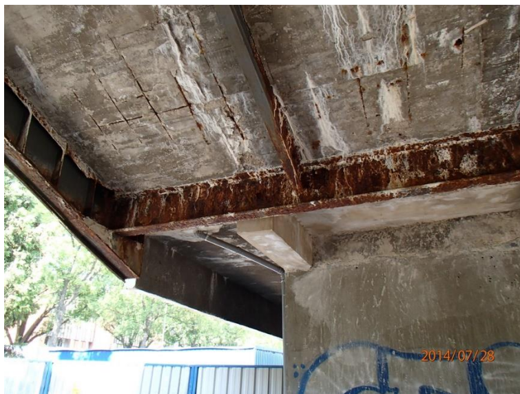
Fot 38. Kładka nr 1, widok od spodu przy wydziale ekonomii.
