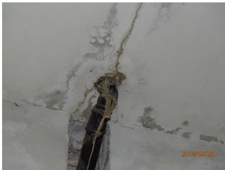
Fot 82. Spód, Kładka nr 2, przy bibliotece.
