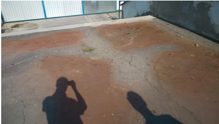
Fot 65. Kładka nr 1, powierzchnia.
