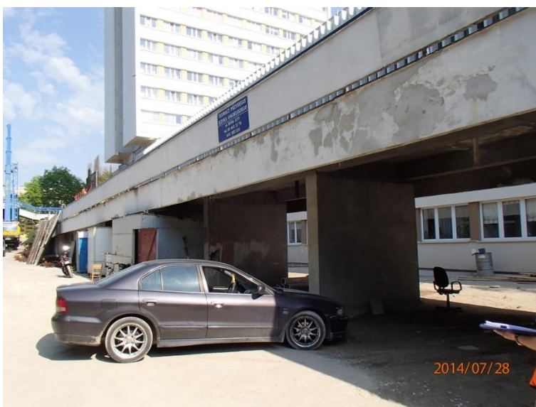
Fot 10. Elewacja Kładka nr 1
