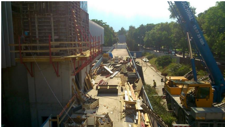
Fot 66. Kładka nr 1, powierzchnia.
