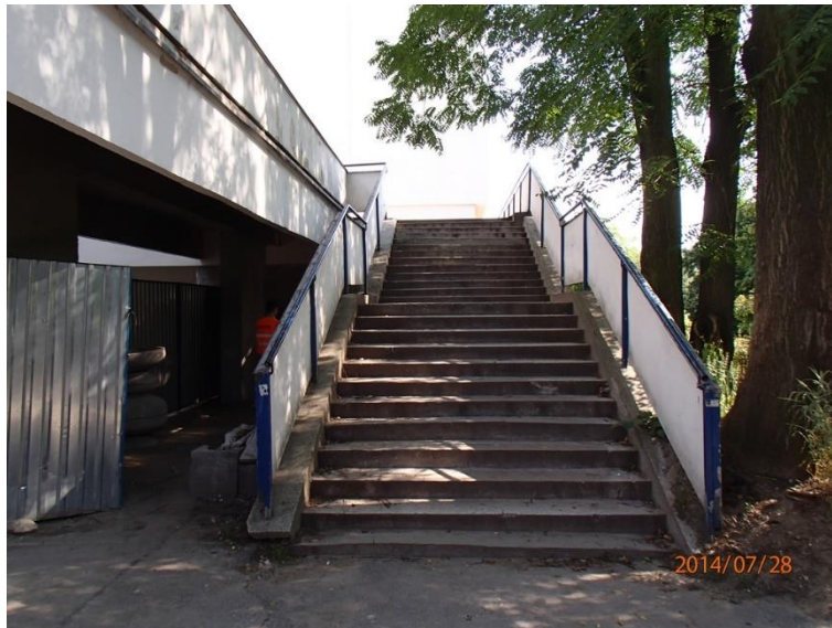
Fot 124. Schody, Kładka nr 3
