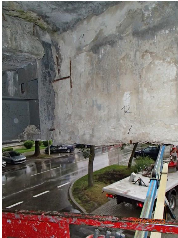
Fot 107. Spód, Kładka nr 2, przy szlabanie. Wjazd do rektoratu.
