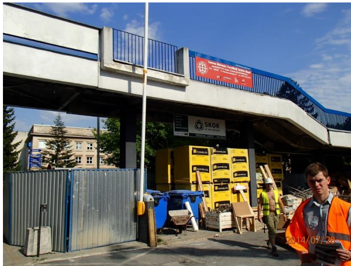
Fot 68. Kładka nr 2, elewacja
