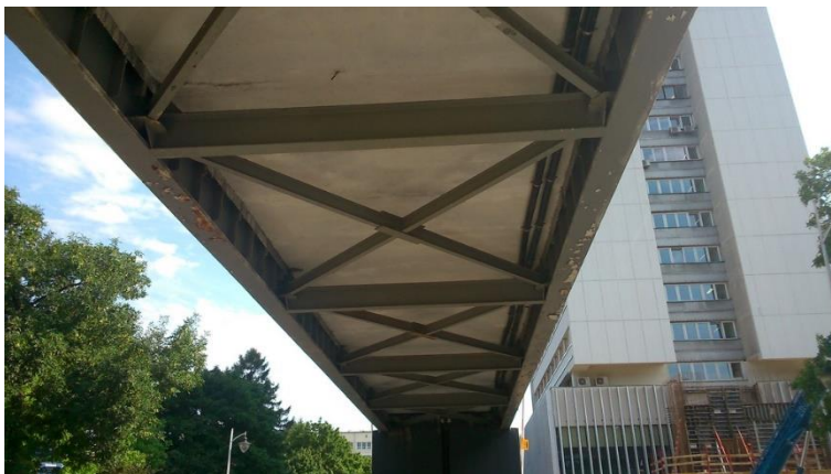
Fot 79. Spód, Kładka nr 2, przy bibliotece.
