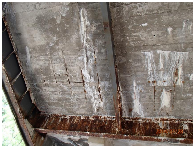
Fot 40. Kładka nr 1, widok od spodu przy wydziale ekonomii.
