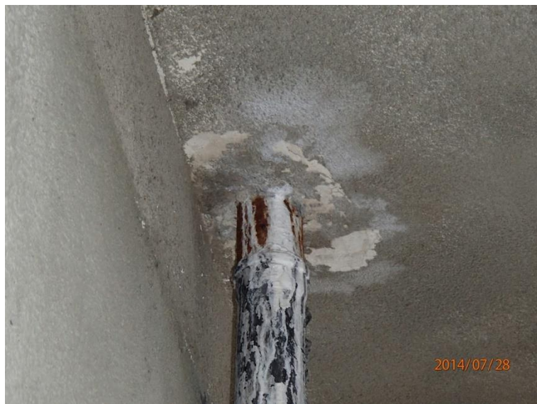
Fot 129. Kładka nr 3, od spodu
