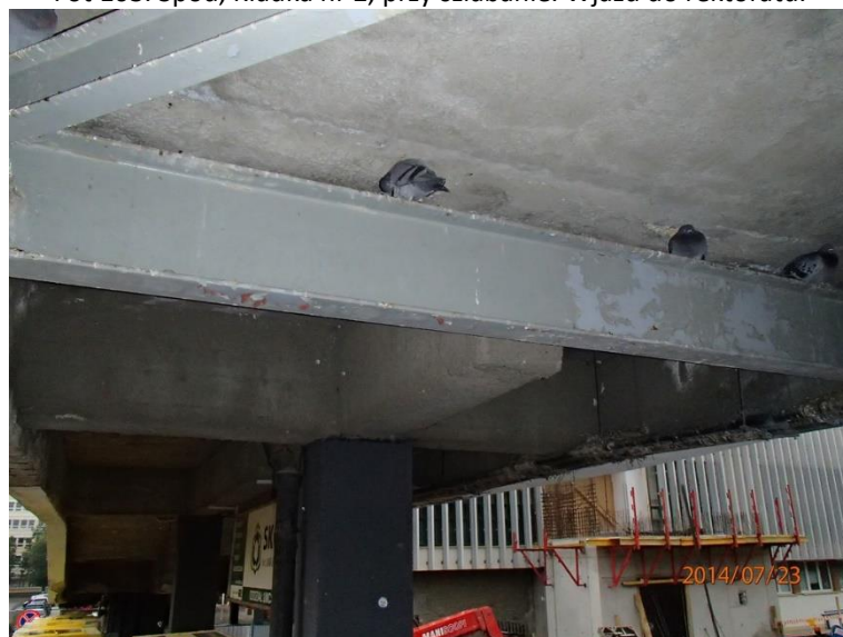
Fot 104. Spód, Kładka nr 2, przy szlabanie. Wjazd do rektoratu.
