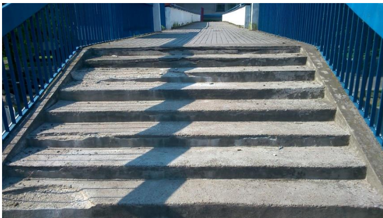
Fot 120. Barierki, schody, Kładka nr 2, przy rektoracie.
