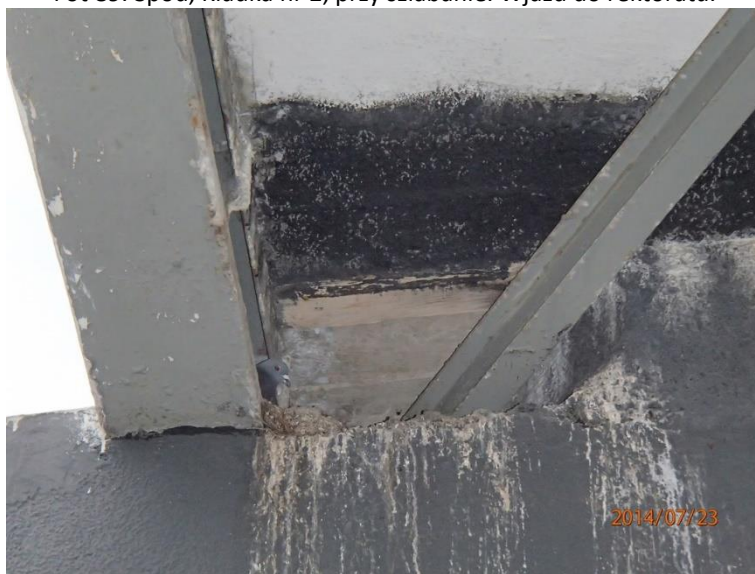
Fot 90. Spód, Kładka nr 2, przy szlabanie. Wjazd do rektoratu.
