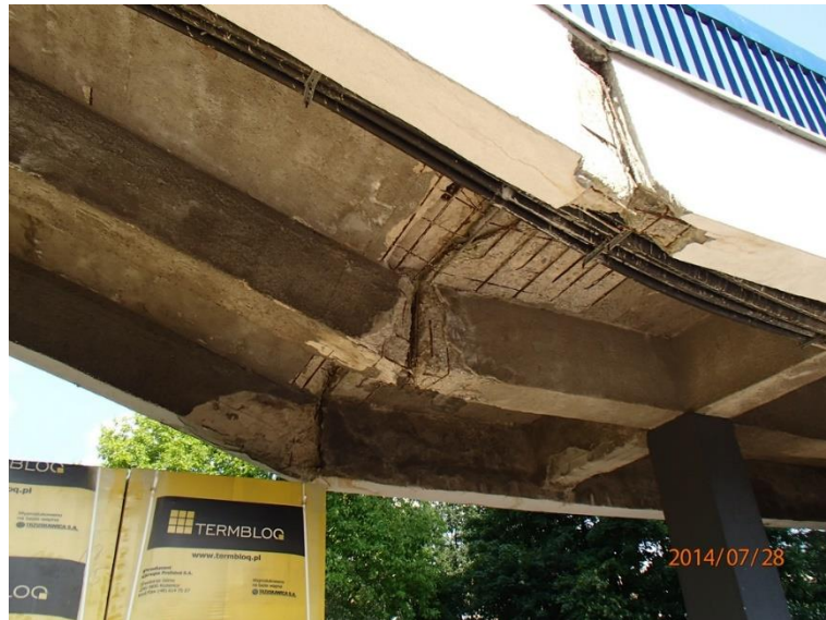
Fot 97. Spód, Kładka nr 2, przy szlabanie. Wjazd do rektoratu.
