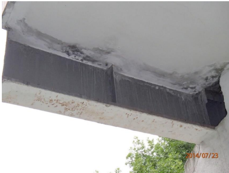
Fot 83. Spód, Kładka nr 2, przy bibliotece.
