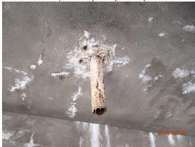
Fot 46. Kładka nr 1, widok od spodu przy wydziale ekonomii.
