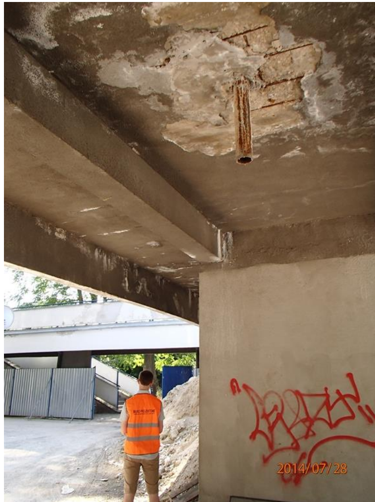
Fot 45. Kładka nr 1, widok od spodu naprzeciw wydziału ekonomii.
