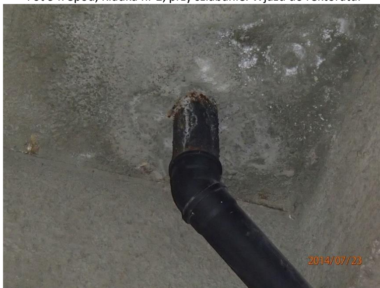
Fot 95. Spód, Kładka nr 2, przy szlabanie. Wjazd do rektoratu.
