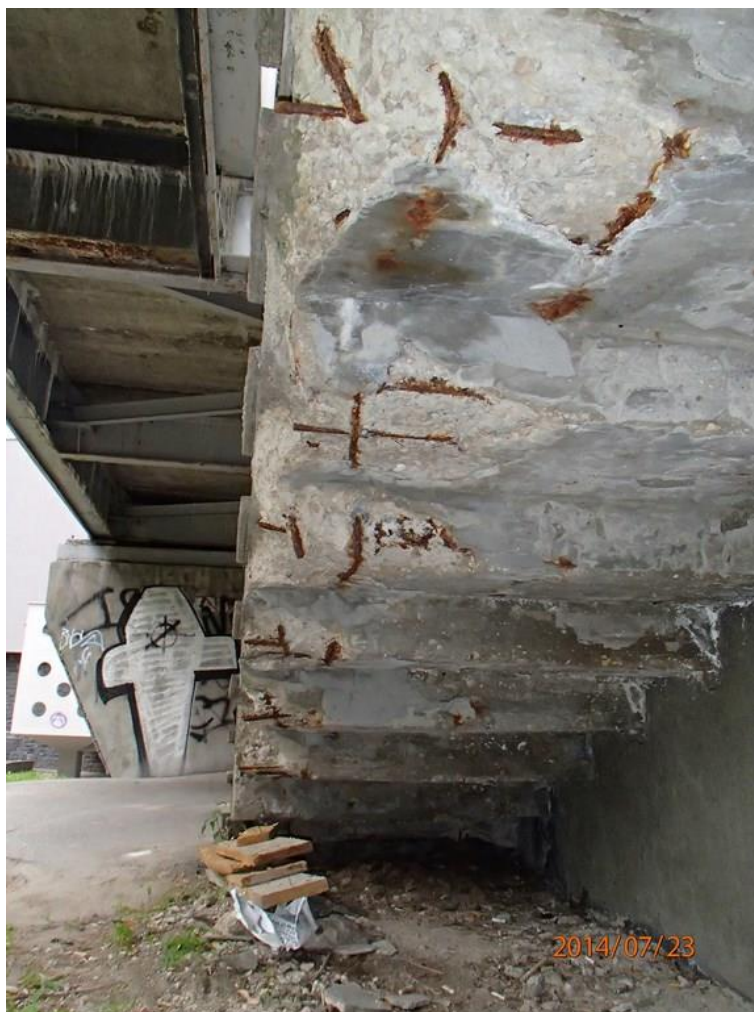
Fot 54. Kładka nr 1, widok od spodu przy chatce Żaka – schody.
