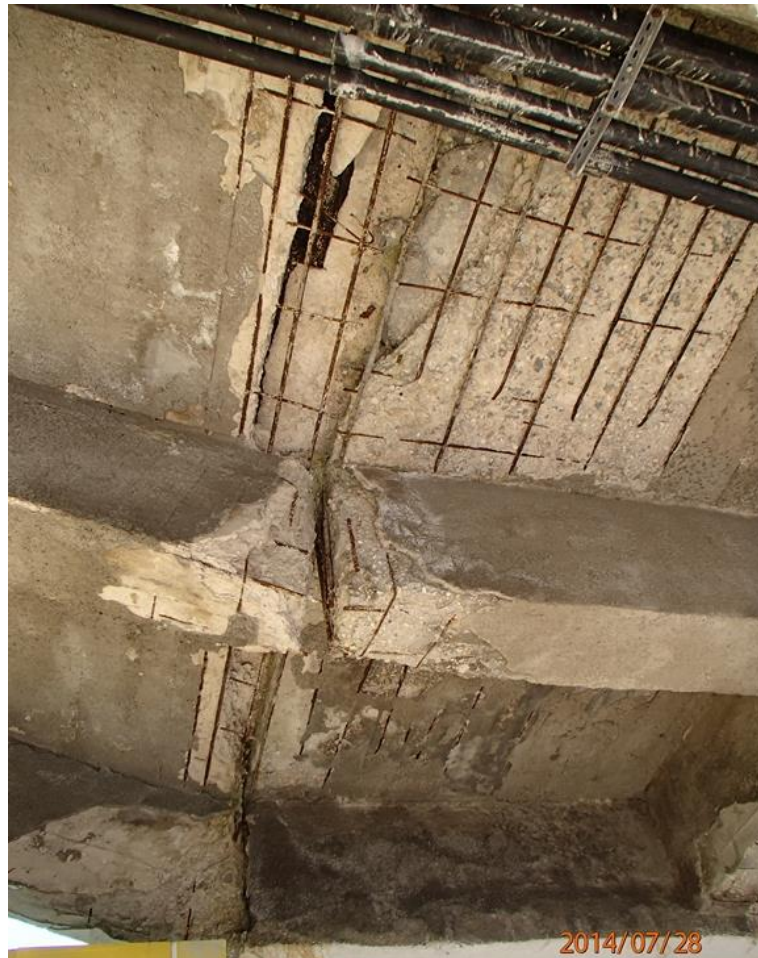
Fot 103. Spód, Kładka nr 2, przy szlabanie. Wjazd do rektoratu.
