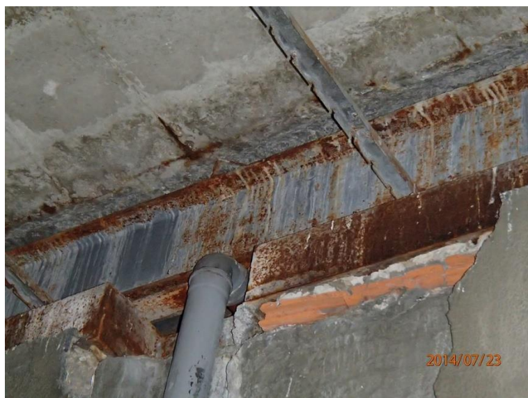
Fot 23. Kładka nr 1, widok od spodu przy kiosku ruchu.
