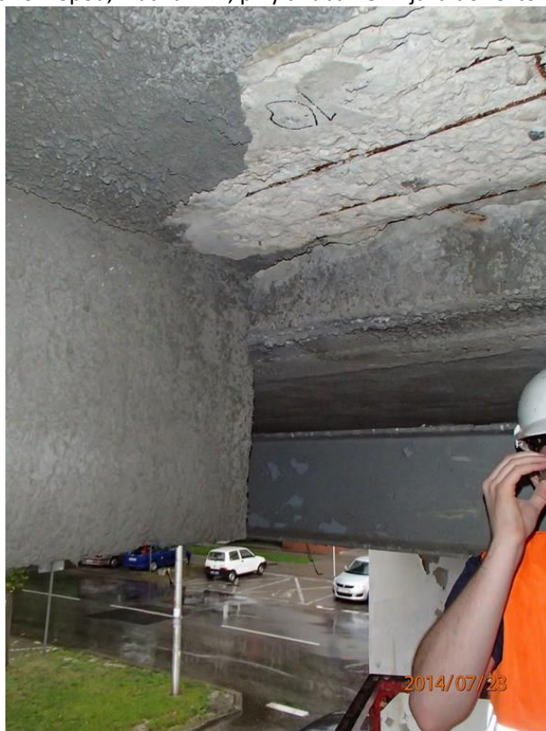
Fot 108. Spód, Kładka nr 2, przy szlabanie. Wjazd do rektoratu.
