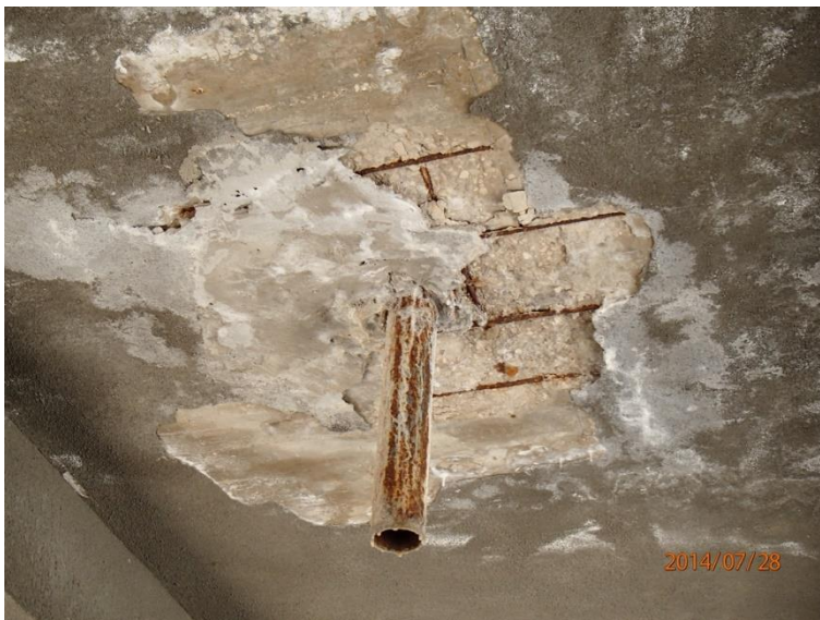
Fot 47. Kładka nr 1, widok od spodu przy wydziale ekonomii.
