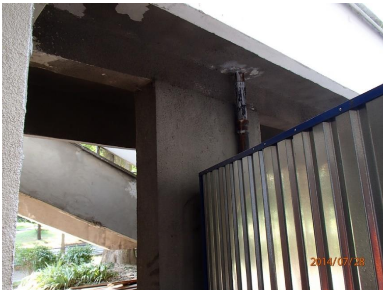
Fot 130. Kładka nr 3, od spodu
