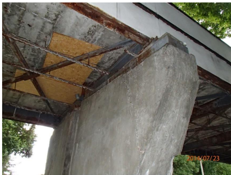
Fot 34. Kładka nr 1, widok od spodu po stronie wydziału ekonomii.
