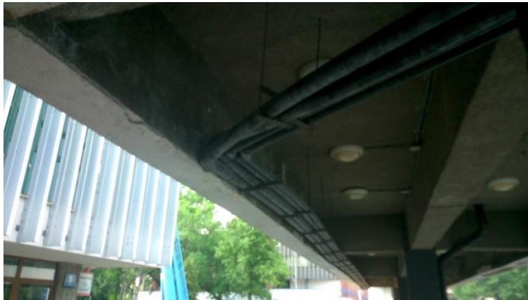
Fot 75. Spód, Kładka nr 2, przy rektoracie.
