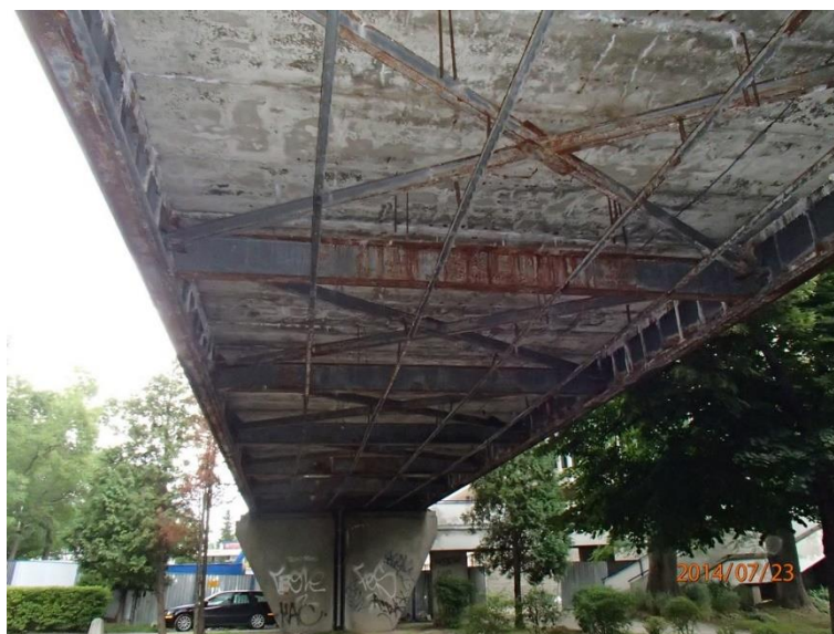
Fot 25. Kładka nr 1, widok od spodu przy kiosku ruchu.
