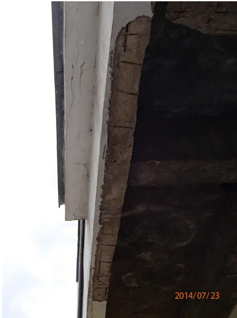
Fot 92. Spód, Kładka nr 2, przy szlabanie. Wjazd do rektoratu.
