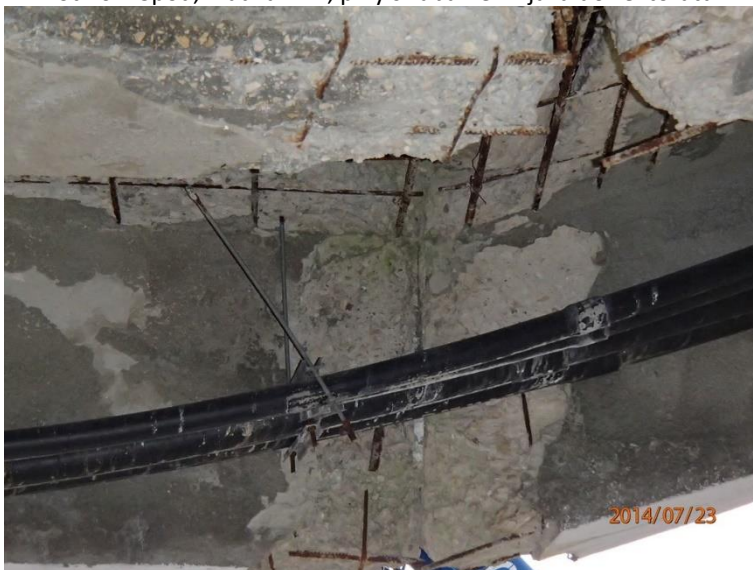
Fot 102. Spód, Kładka nr 2, przy szlabanie. Wjazd do rektoratu.
