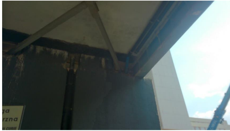
Fot 80. Spód, Kładka nr 2, przy ul. Radziszewskiego.
