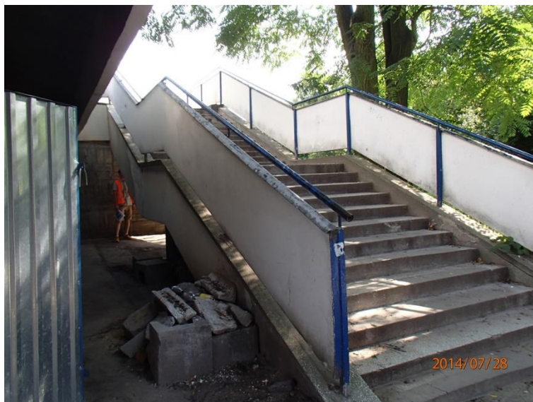
Fot 125. Schody, Kładka nr 3
