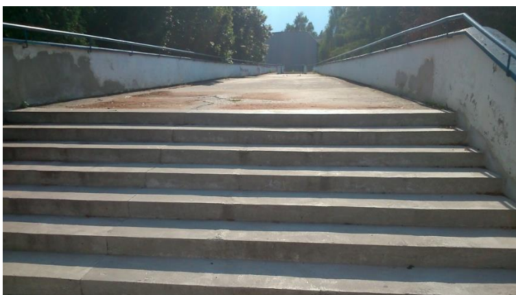
Fot 49. Kładka nr 1, schody.
