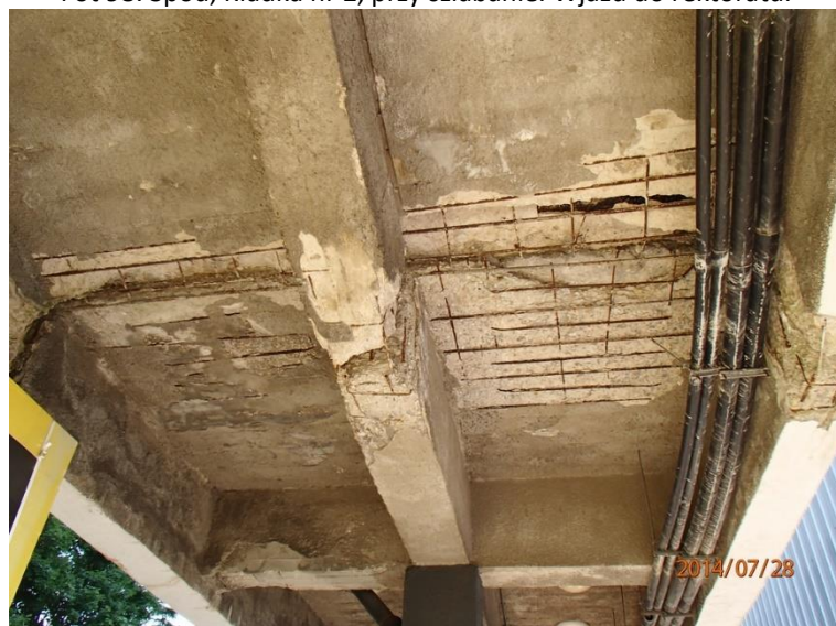
Fot 99. Spód, Kładka nr 2, przy szlabanie. Wjazd do rektoratu.
