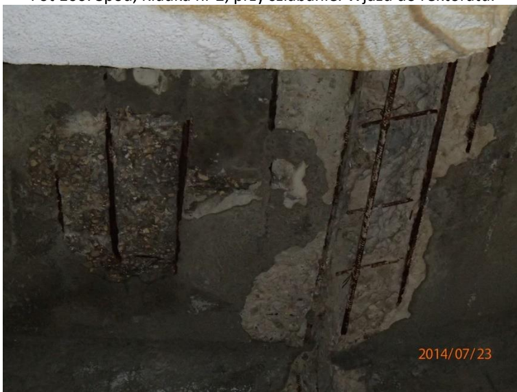
Fot 101. Spód, Kładka nr 2, przy szlabanie. Wjazd do rektoratu.
