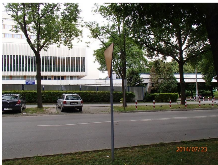
Fot 7. Elewacja Kładka nr 1
