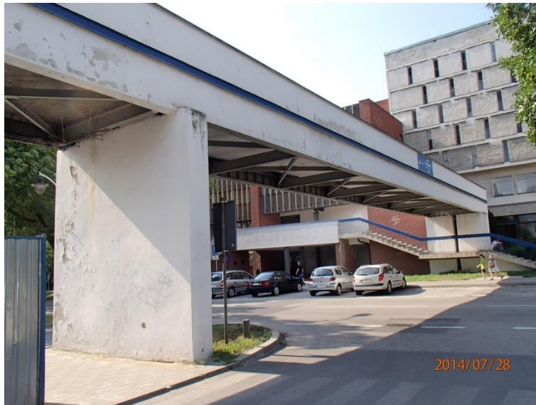
Fot 71. Kładka nr 2, elewacja
