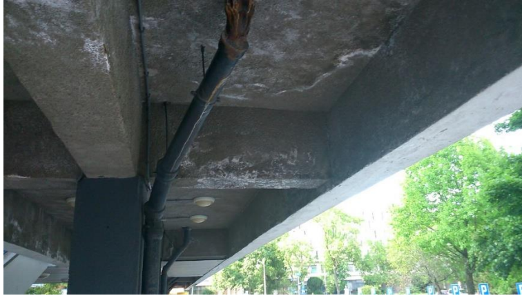
Fot 73. Spód, Kładka nr 2 przy rektoracie.
