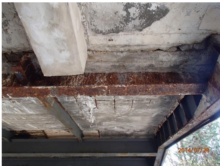
Fot 43. Kładka nr 1, widok od spodu przy wydziale ekonomii.
