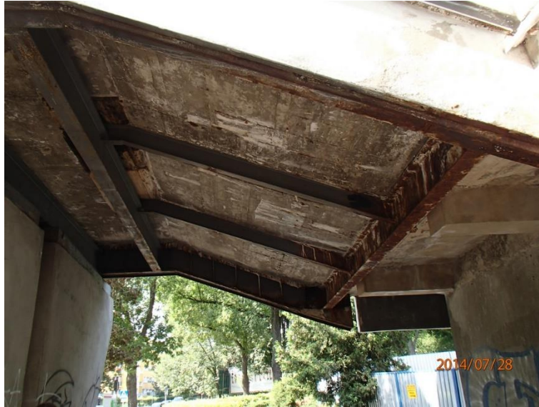
Fot 36. Kładka nr 1, widok od spodu przy wydziale ekonomii.
