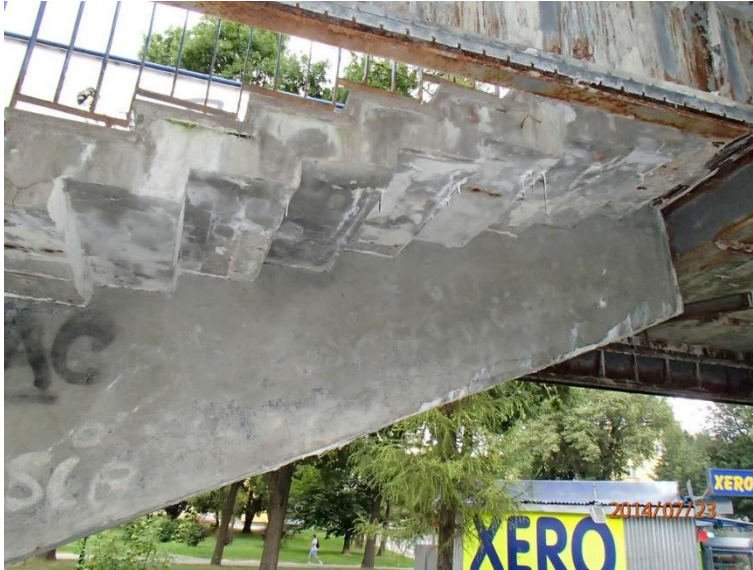
Fot 57. Kładka nr 1, widok od spodu przy chatce Żaka – schody.
