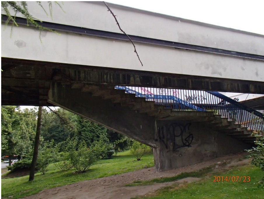
Fot 4. Elewacja Kładka nr 1
