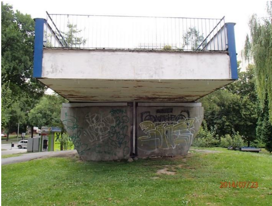
Fot 3. Elewacja Kładka nr 1
