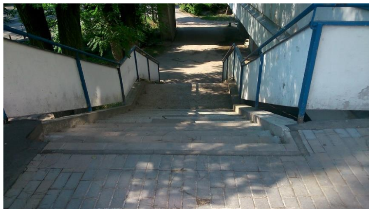
Fot 123. Schody, Kładka nr 3
