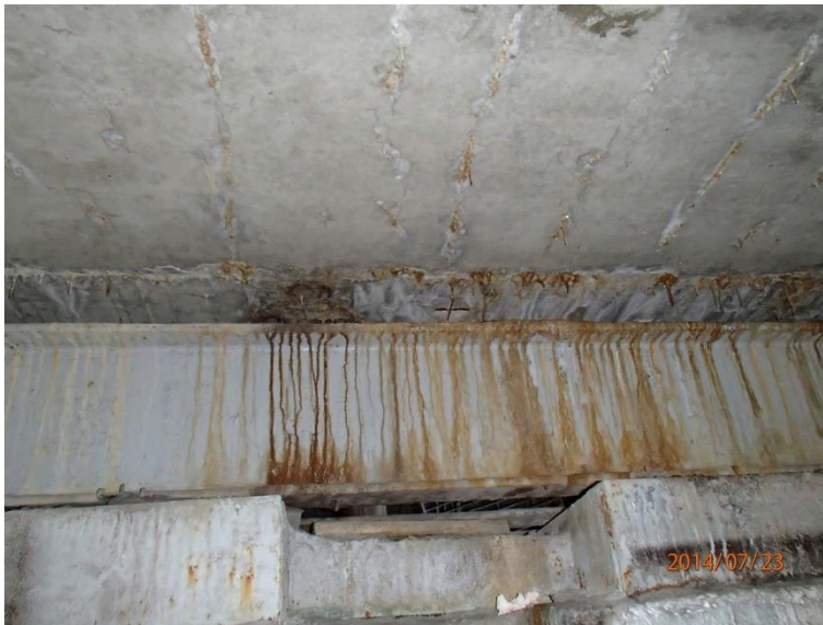
Fot 14. Kładka nr 1, widok od spodu przy kiosku ruchu.
