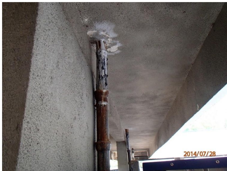
Fot 128. Kładka nr 3, od spodu
