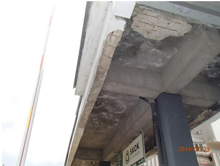
Fot 89. Spód, Kładka nr 2, przy szlabanie. Wjazd do rektoratu.
