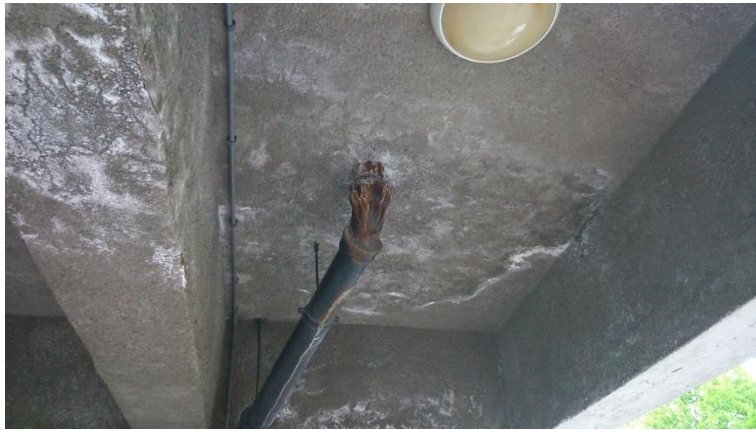
Fot 74. Spód, Kładka nr 2 przy rektoracie.
