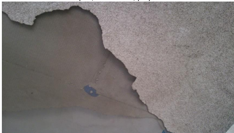
Fot 85. Spód, Kładka nr 2, przy bibliotece.
