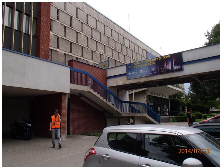
Fot 72. Kładka nr 2, elewacja
