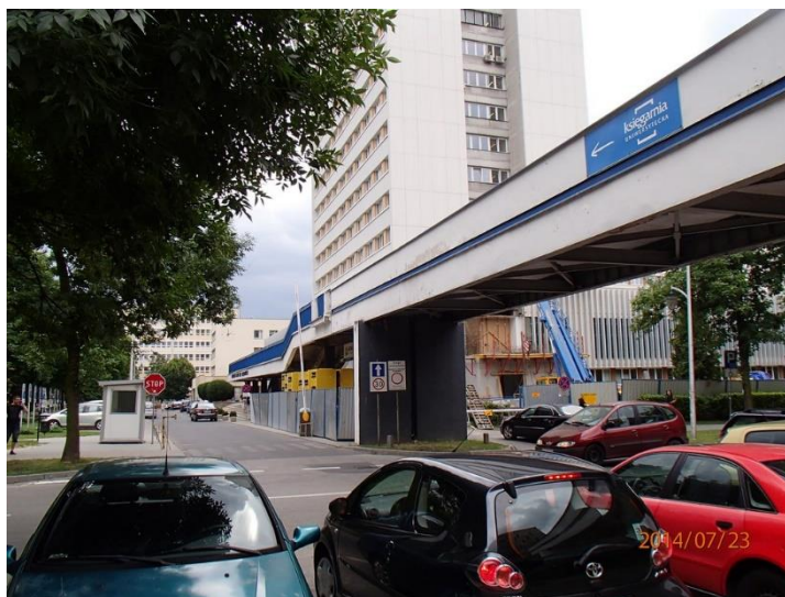
Fot 69. Elewacja Kładka nr 2
