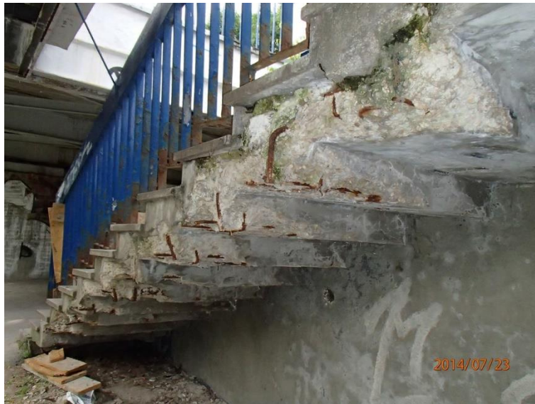
Fot 53. Kładka nr 1, widok od spodu przy chatce Żaka – schody.
