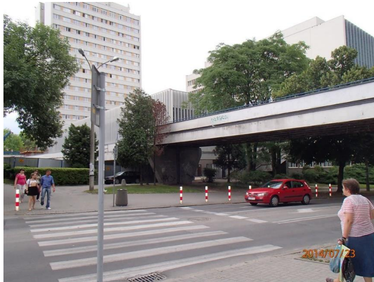
Fot 5. Elewacja Kładka nr 1
