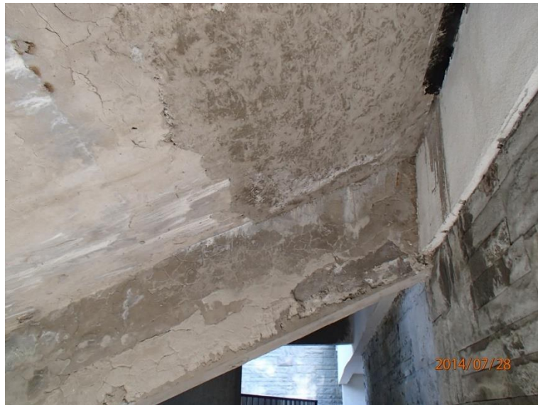
Fot 127. Schody, Kładka nr 3
