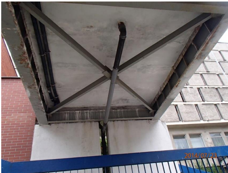
Fot 78. Spód, Kładka nr 2, przy bibliotece.
