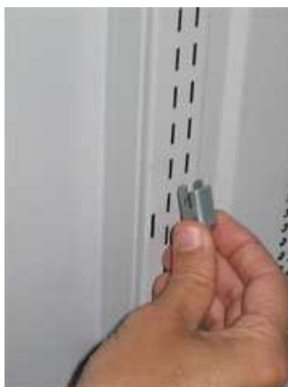
Fot. Szczegóły prowadnic i montaż półek
