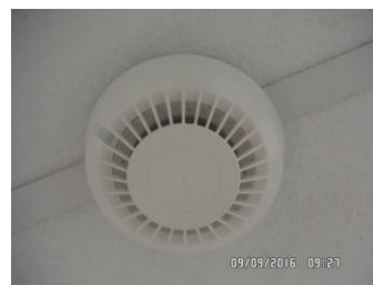
sygnalizator pożaru ręczny ostrzegacz pożaru[ROP] czujka pożarowa
