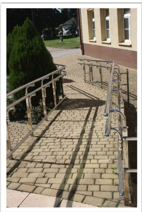
Podjazd z drugiej strony budynku.
