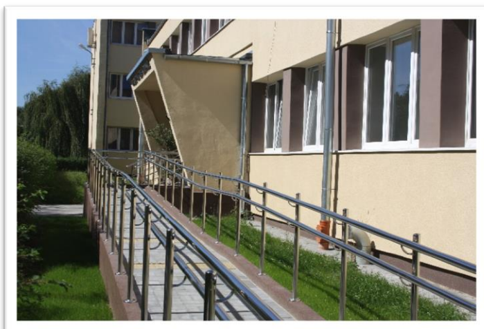
Podjazd do budynku przy ul. Glinianej 33
