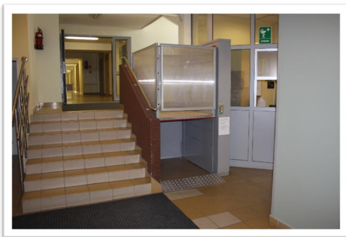
Platforma pionowa wewnątrz budynku na parterze.
