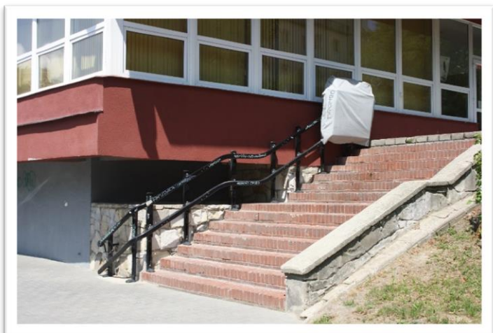
Wejście do budynku z platformą przyschodową od strony Centrum kultury Fizycznej UMCS.
