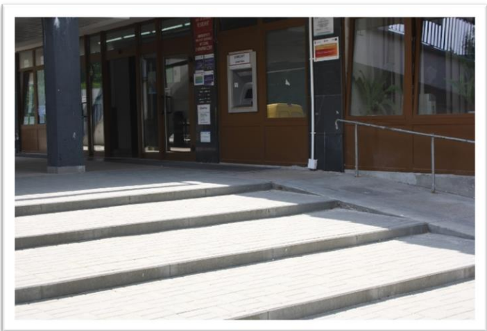
Wejście główne z podjazdem.
