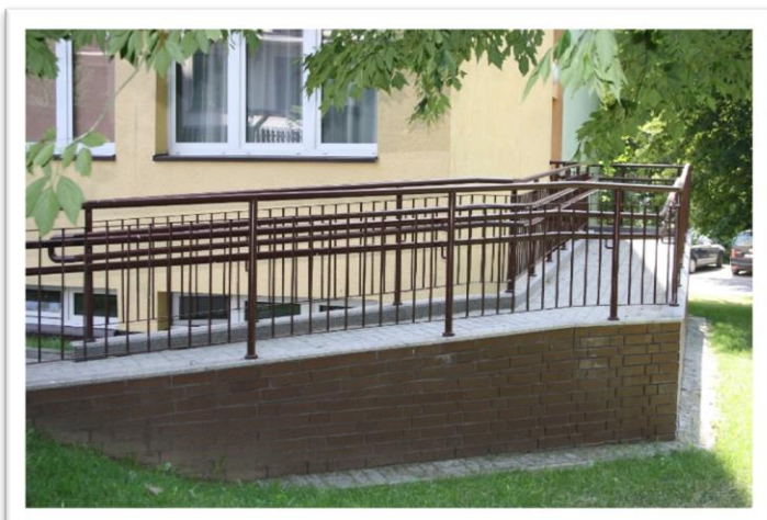
Podjazd dla osób niepełnosprawnych z tyłu budynku, kontakt z portiernią przez domofon.
