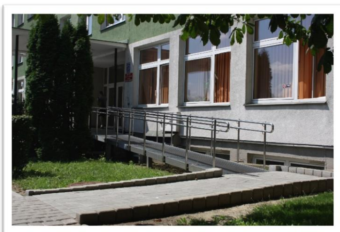
Podjazd przy głównym wejściu do domu studenckiego.
