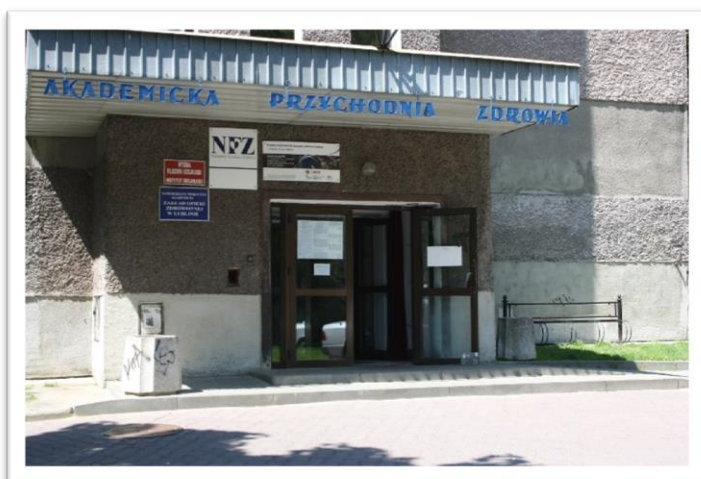
Wejście do budynku z podjazdem.
