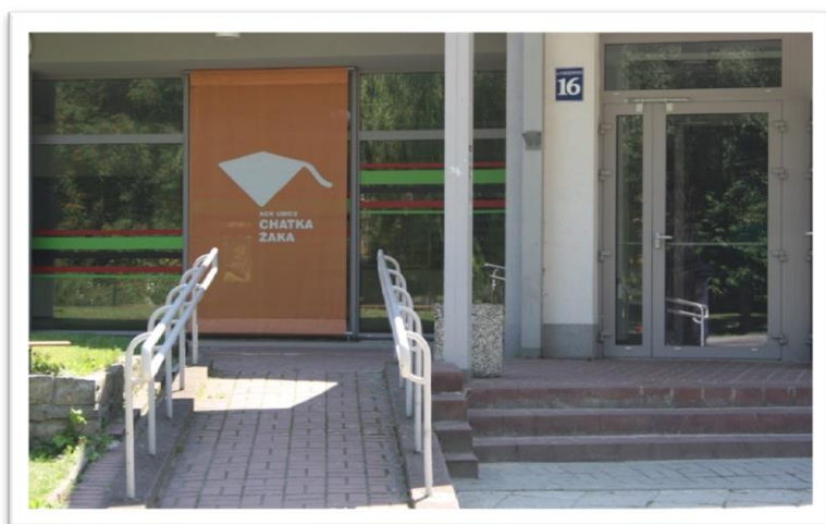
Podjazd na zewnątrz budynku
